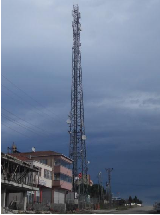
Şekil 4.21. Erfelek Yolu Üzerinde Bulunan Baz İstasyonu Kulesi
