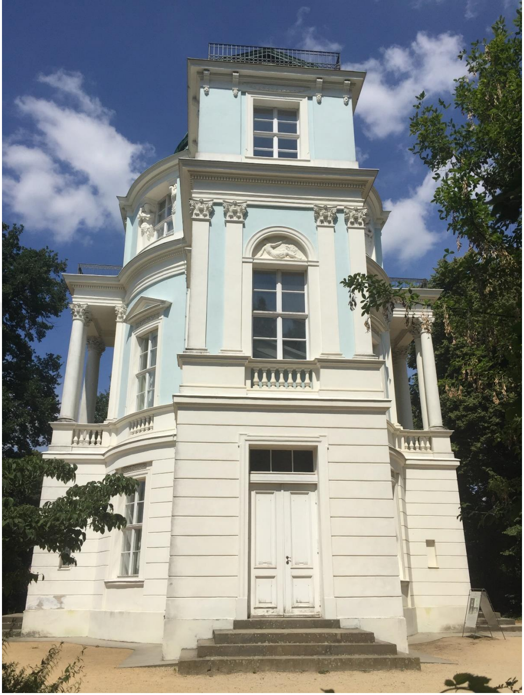
Şekil 106: Belvedere (Hobi Evi) Güney Cephesi.
