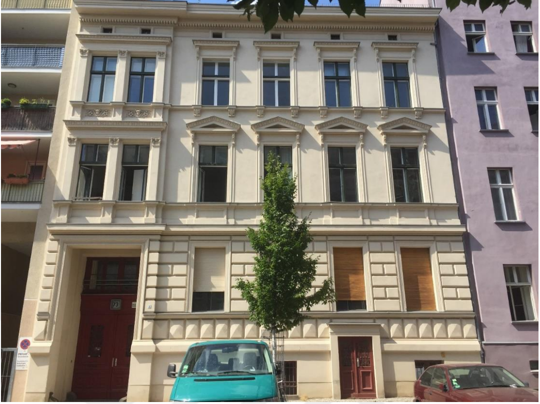
Şekil 256: Rheinsberger Strasse 73. ( Konut ) Güney Cephesi.
