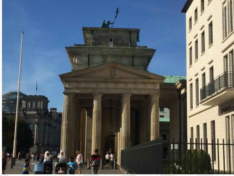
Şekil 123: Brandenburger Tor (Brandenburg Kapısı) Güney Cephesi.
