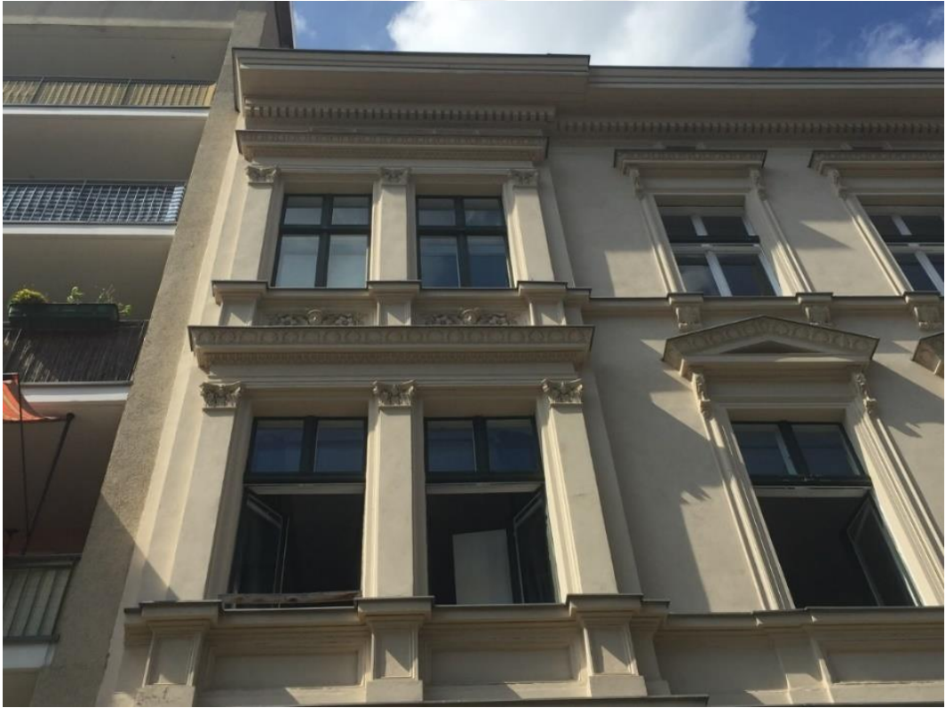
Şekil 257: Rheinsberger Strasse 73. ( Konut ) Güney Cephesinin Batı Bölümü.
