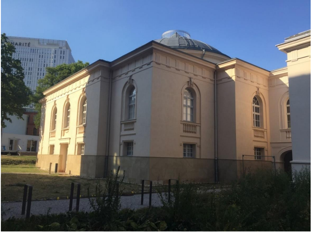
Şekil 117: Anatomisches Theater der Tierarzneischule (Veteriner Okulu Anatomi Tiyatrosu) Güneydoğu Cephesi.
