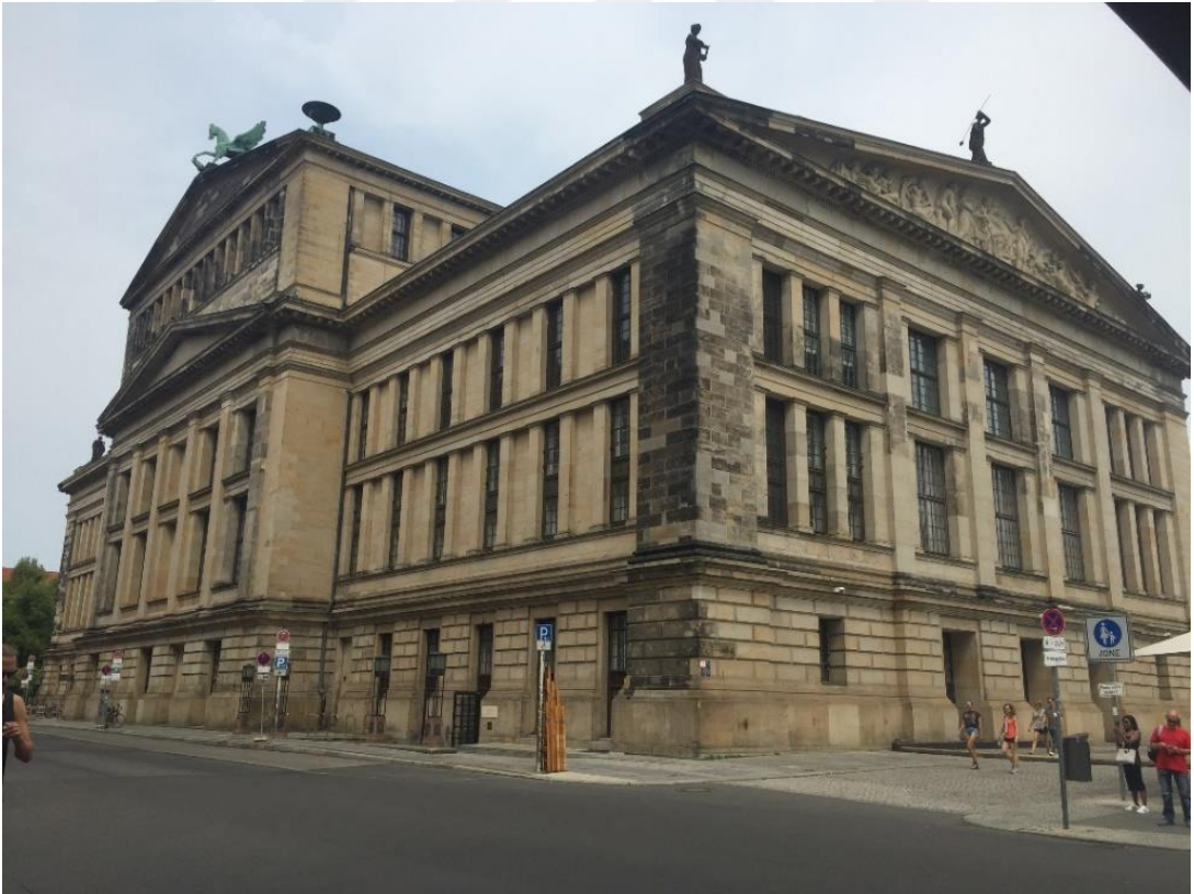
Şekil 179: Schauspielhaus (Konzerthaus- Konser Binası) Batı Cephesi.
