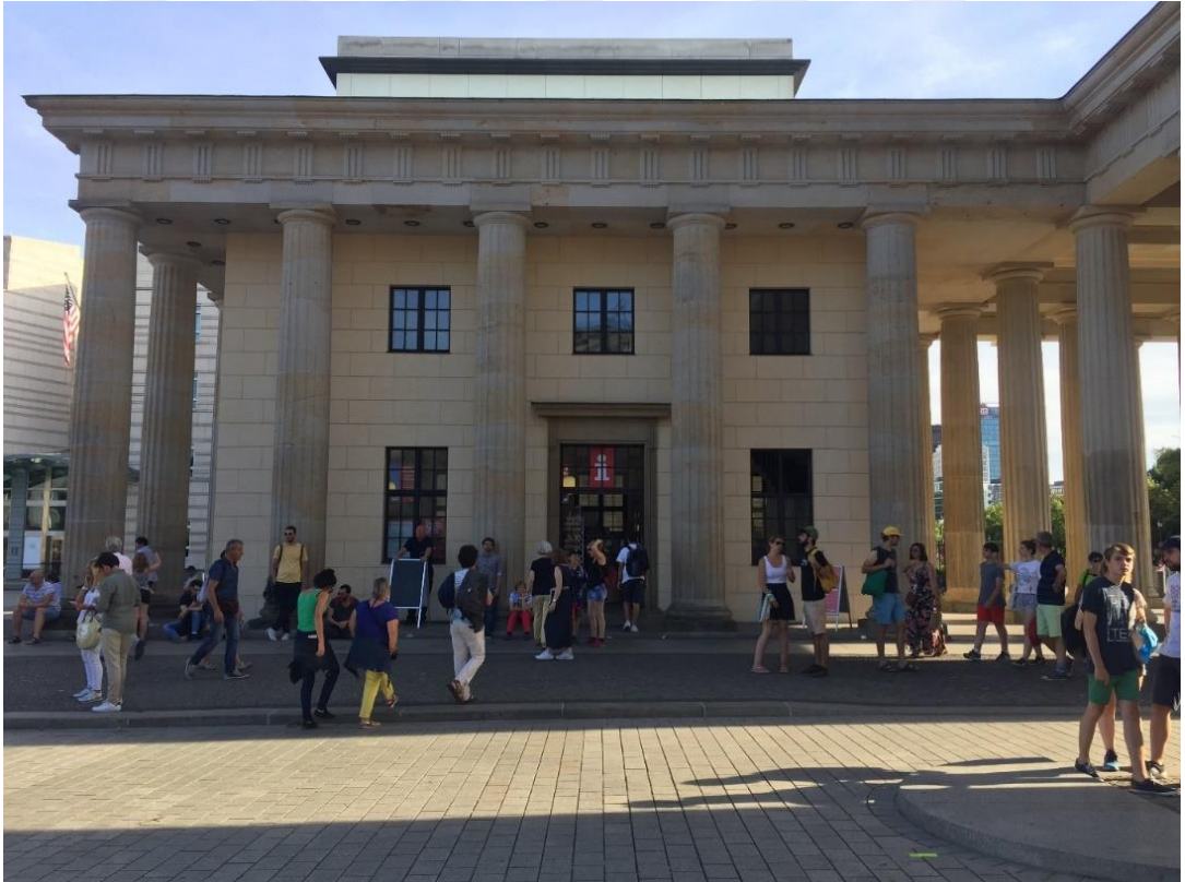
Şekil 126: Brandenburger Tor (Brandenburg Kapısı) Güney Yan Kanadın Kuzey Cehesi.
