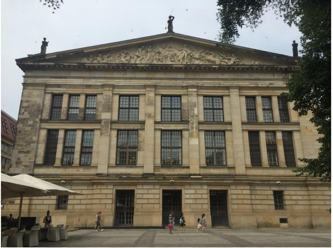
Şekil 178: Schauspielhaus (Konzerthaus- Konser Binası) Güney Cephesi.
