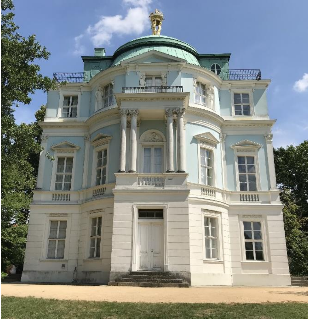
Şekil 104: Belvedere (Hobi Evi) Batı Cephesi.
