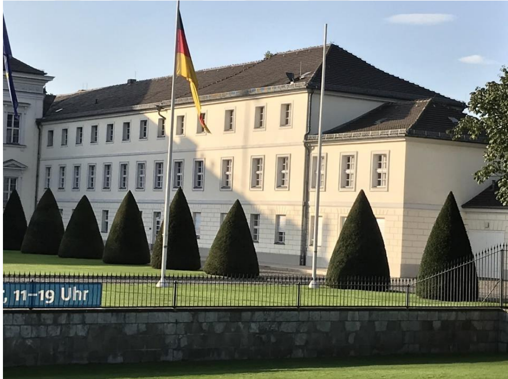
Şekil 100: Bellevue Schloss (Bellevue Sarayı) Kuzeydoğu Kanadın Güneybatı Cephesi.
