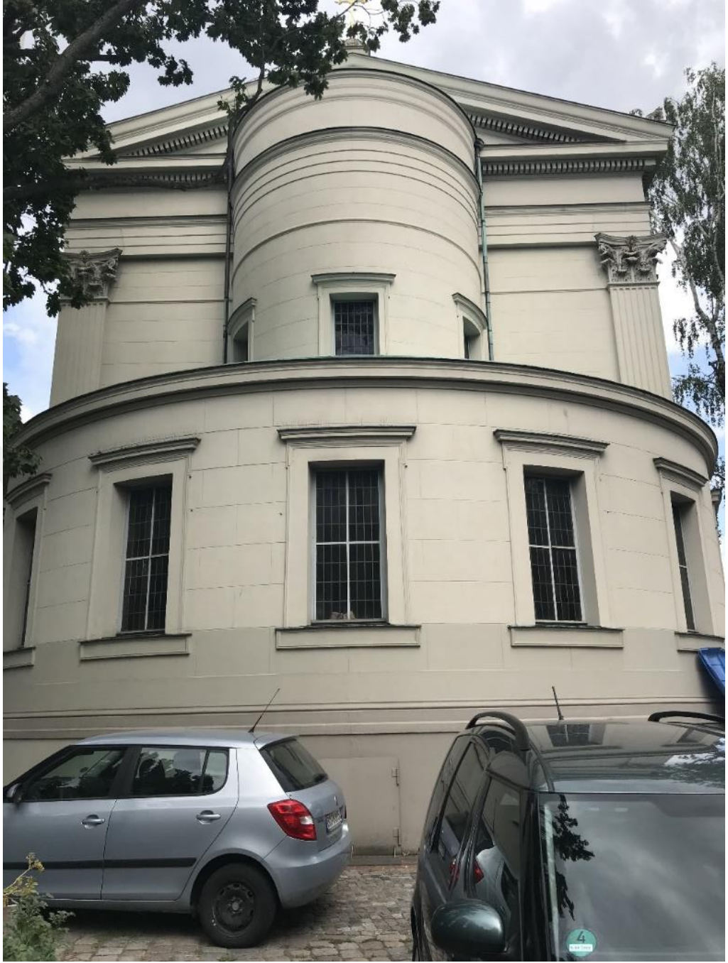
Şekil 214: St. Paul Kirche (Aziz Paul Kilisesi) Doğu Cephesi.
