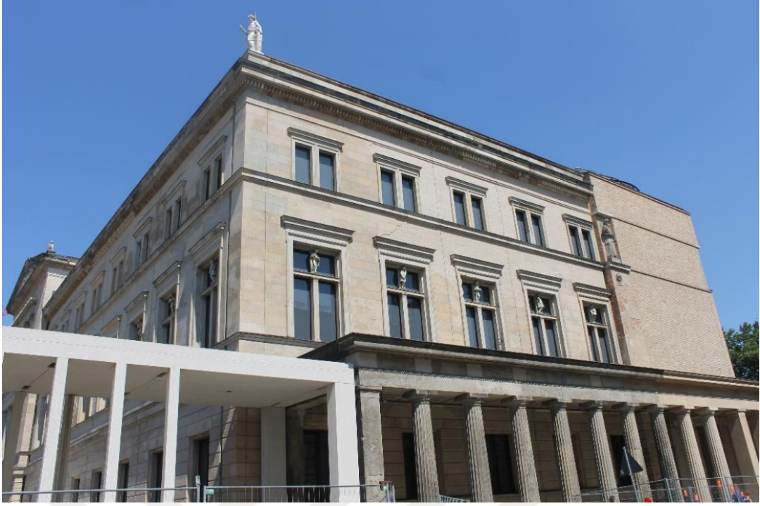
Şekil 233: Neues Museum (Neues Múzesi) Güney Cephesi.
