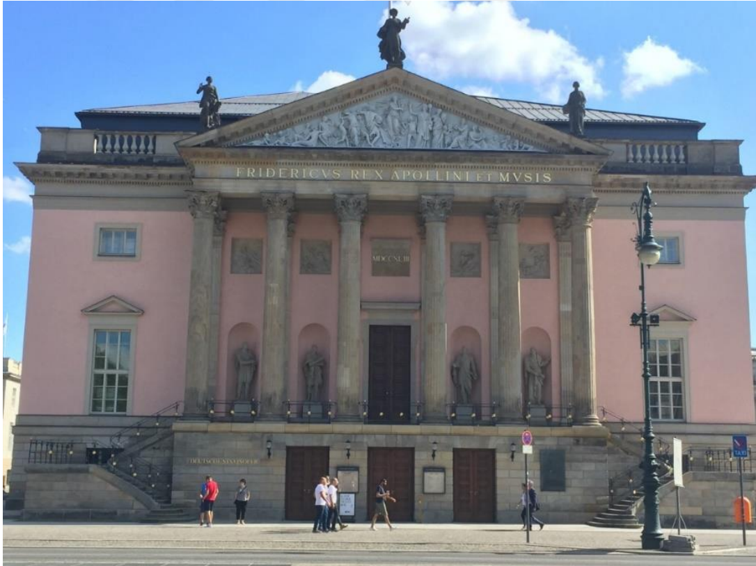
Şekil 38: Staatsoper (Berlin Devlet Operası) Batı Cephesi.
