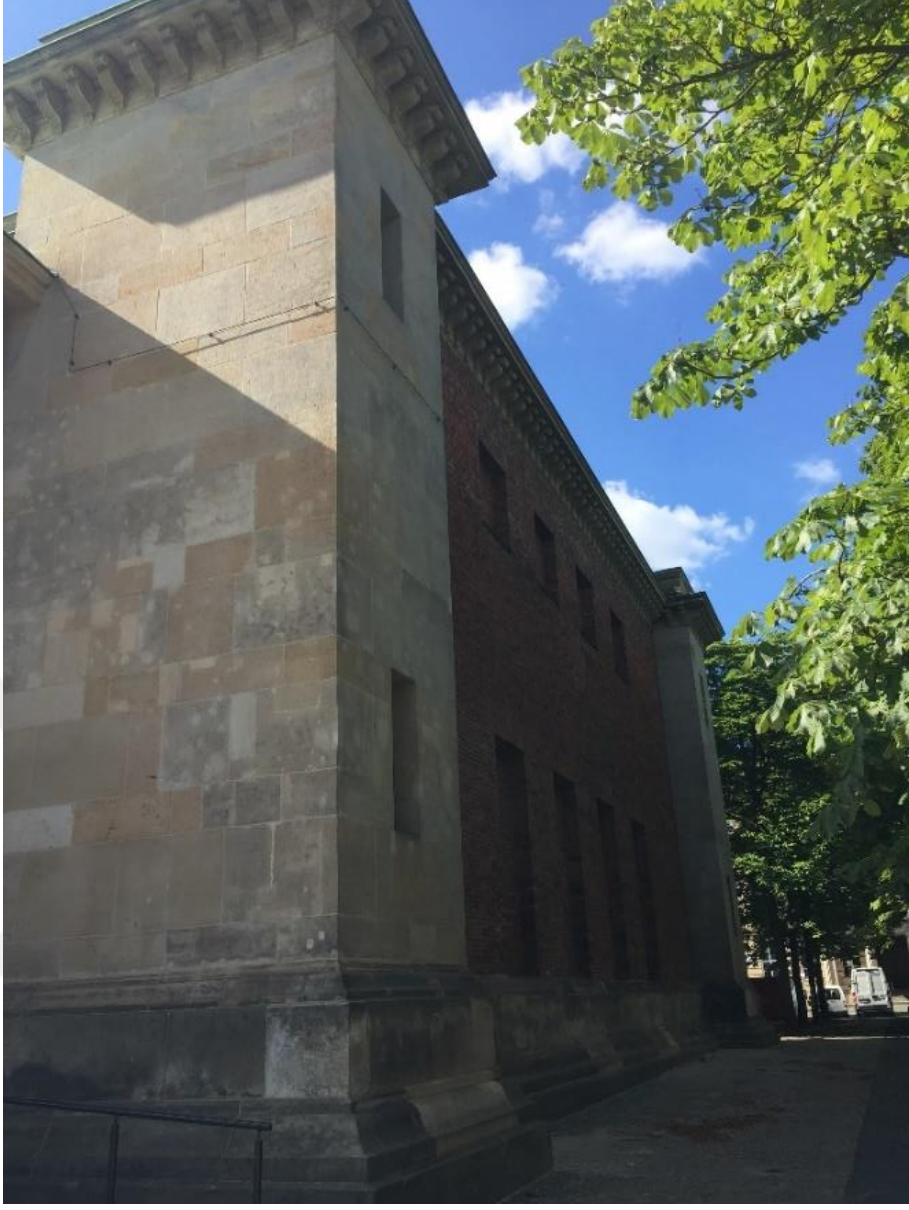
Şekil 171: Neue Wache (Yeni Muhafız Evi) Güneydoğu Cephesi.
