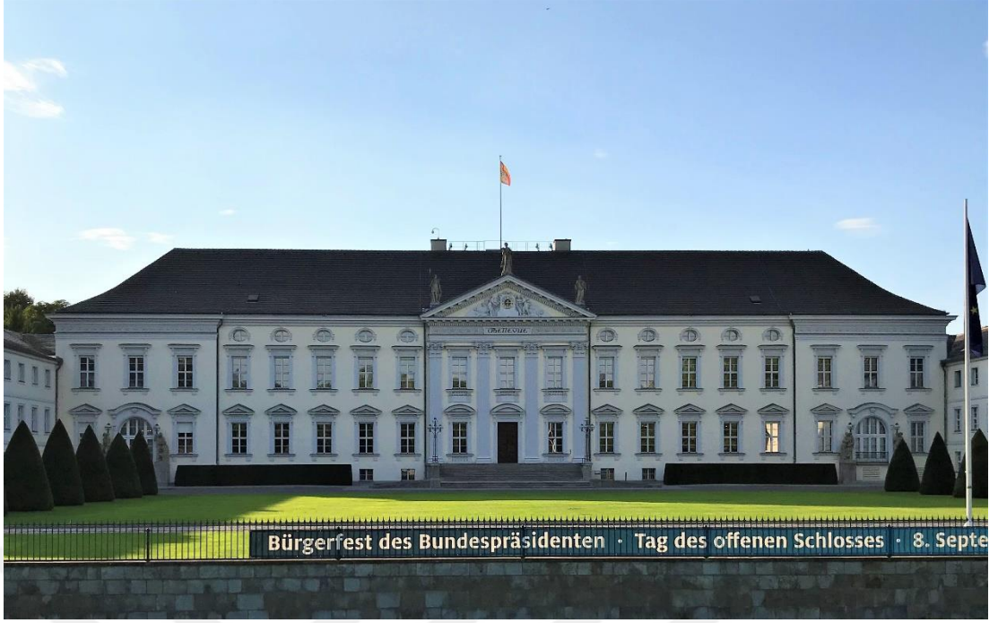
Şekil 99: Bellevue Schloss (Bellevue Sarayı) Orta Kanadın Güneydoğu Cephesi.
