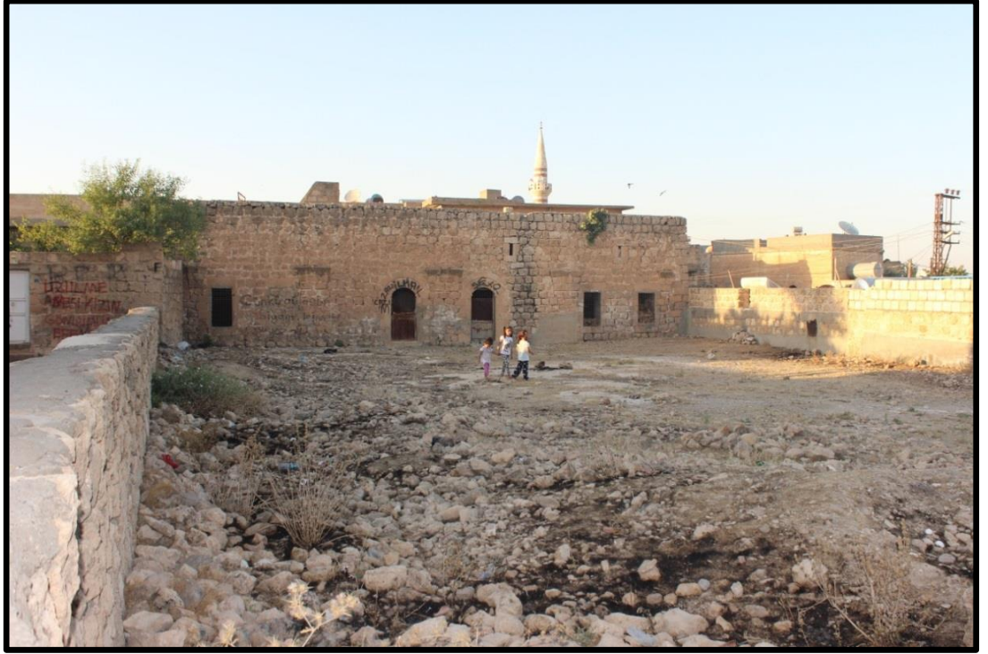
Şekil 57: Boş bırakılmış ve yıkılmak üzere olan geleneksel ev.
