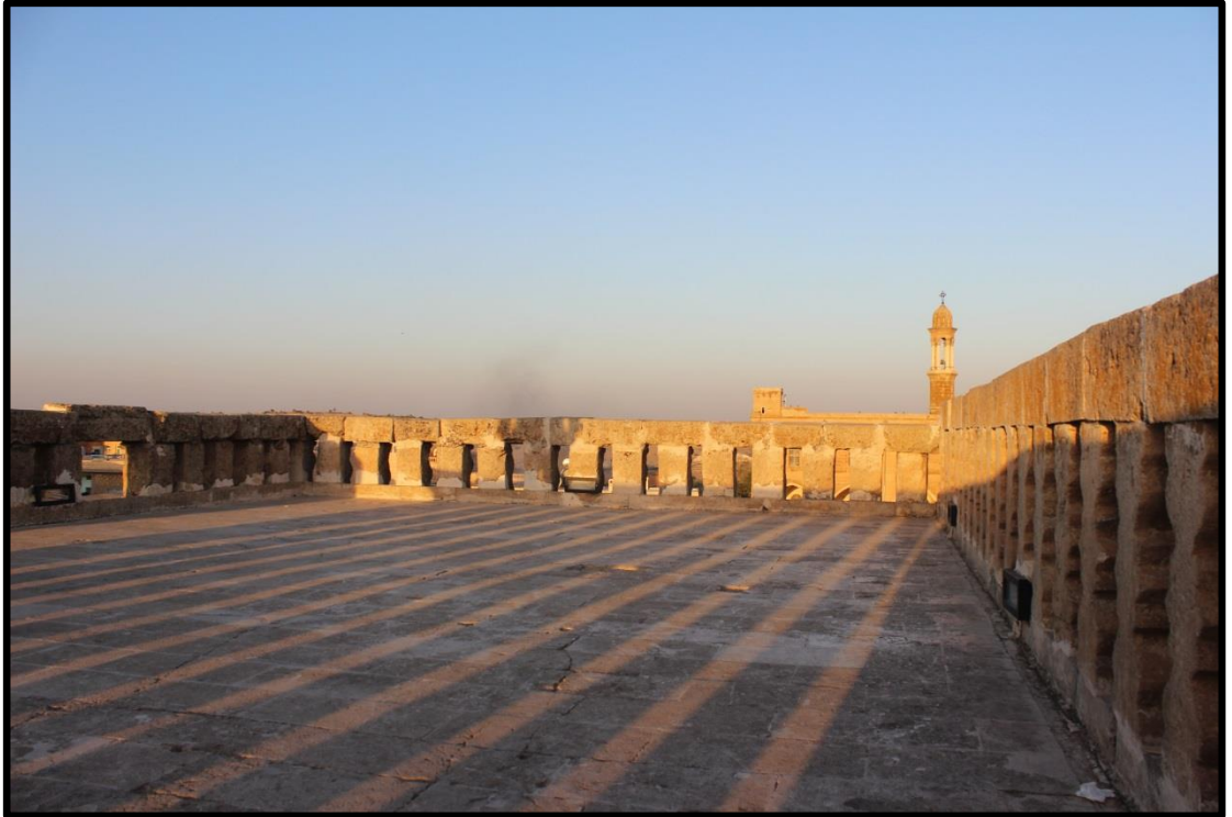
Şekil 19: Etrafı kalker taşlarıyla çevrilmiş geleneksel evlerin damı.
