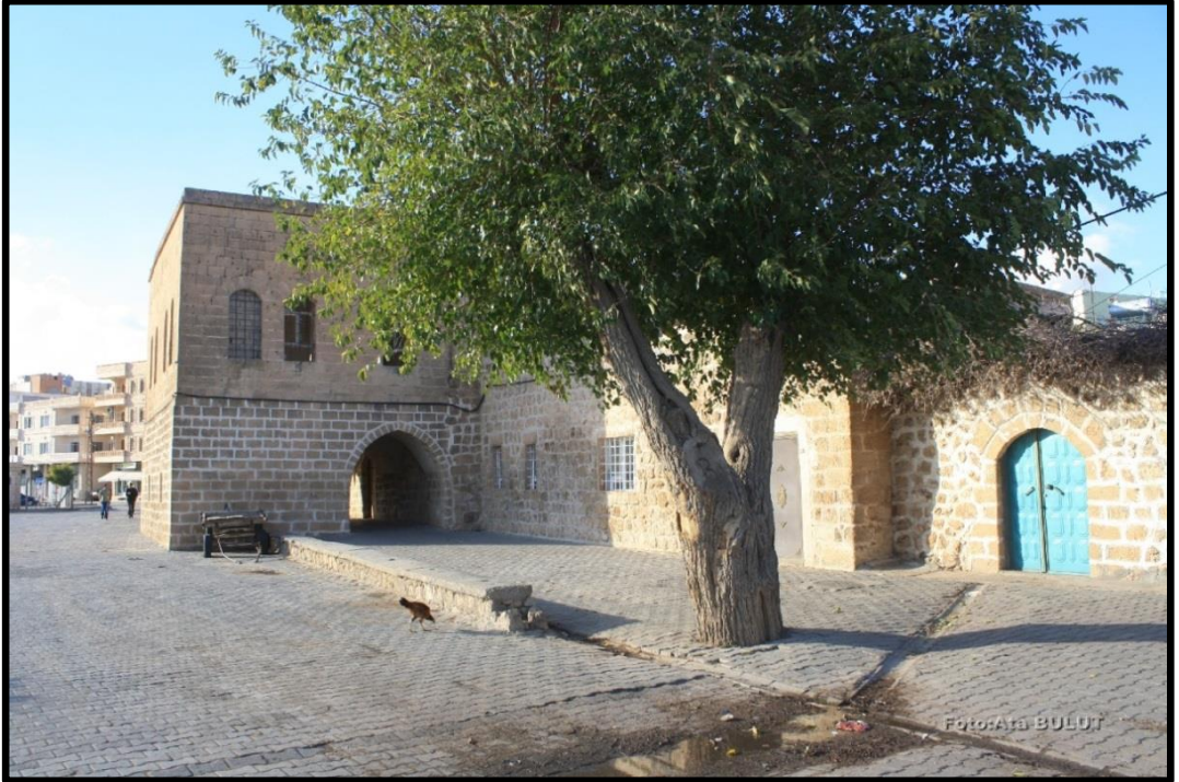
Şekil 22: Gölet doldurularak yeni yol yapılmıştır (Foto Bulut).
