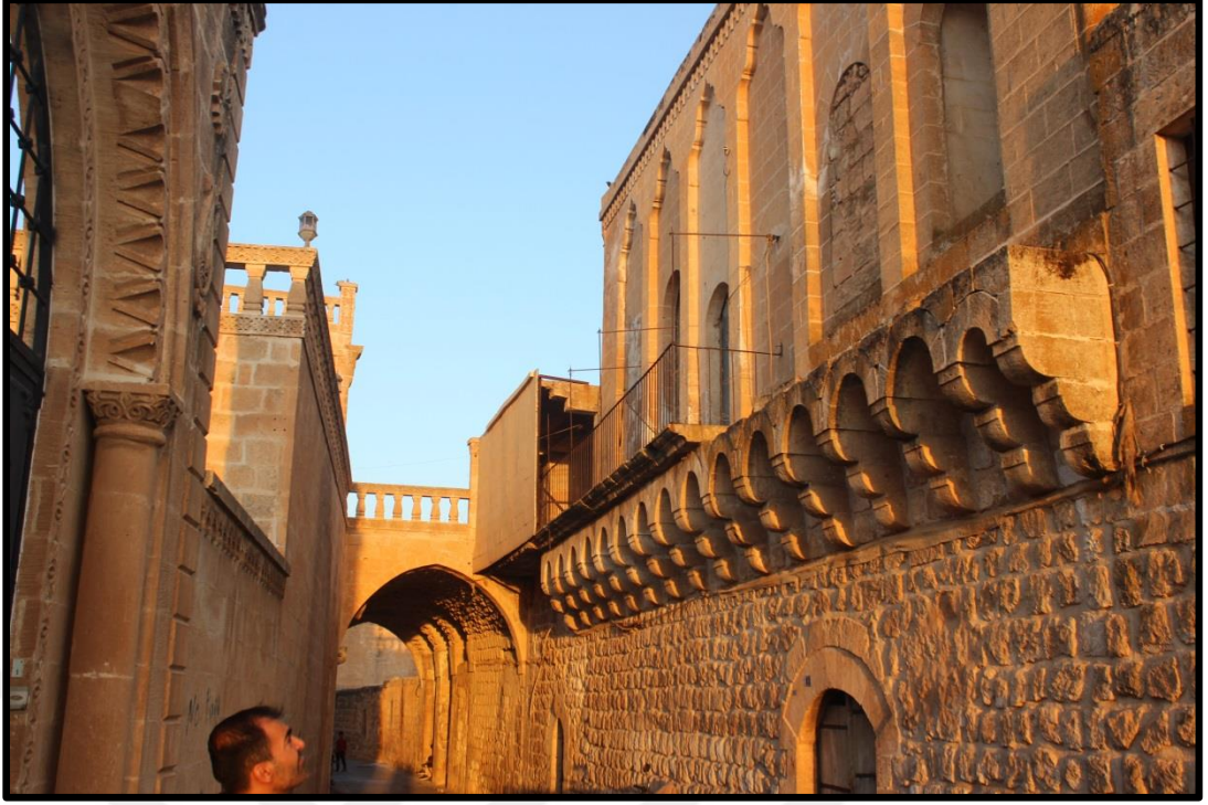
Şekil 23: İki evi birleştirmek için yapılan Abbaralı geçiş(Akcakaya Mahallesi 147. Sokak).
