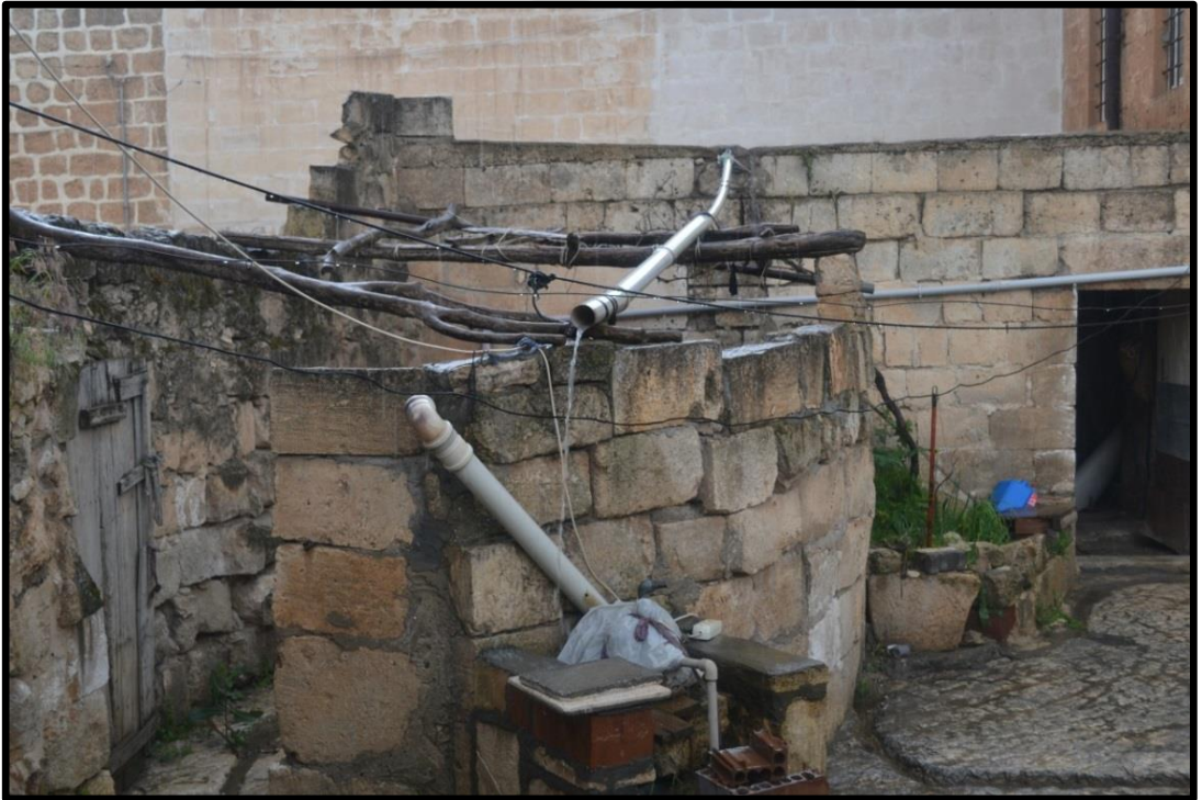
Şekil 36: Dam suyunun borularla tahliye edilmesi.
