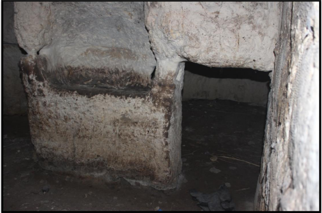
Şekil 14: Geleneksel Midyat evleri altında ana kayanın oyulmasıyla yapılmış bir hayvan barınağı.
