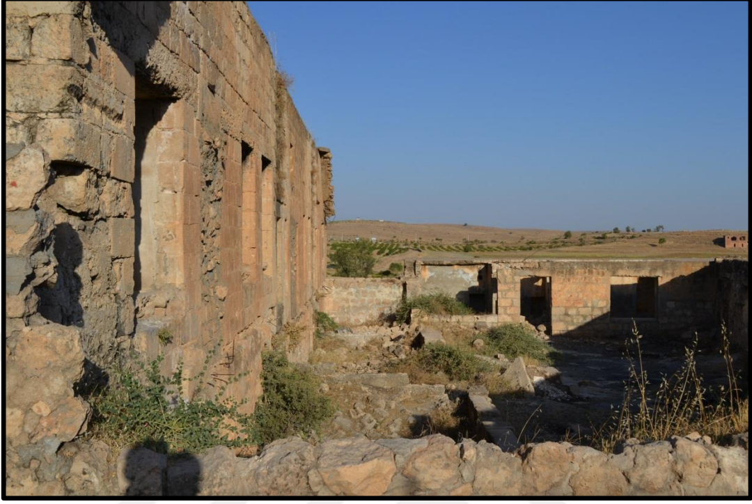
Şekil 41: Akçakaya Mahallesi Manastır Caddesi No:78, Harabe evin batıdan görünümü.
