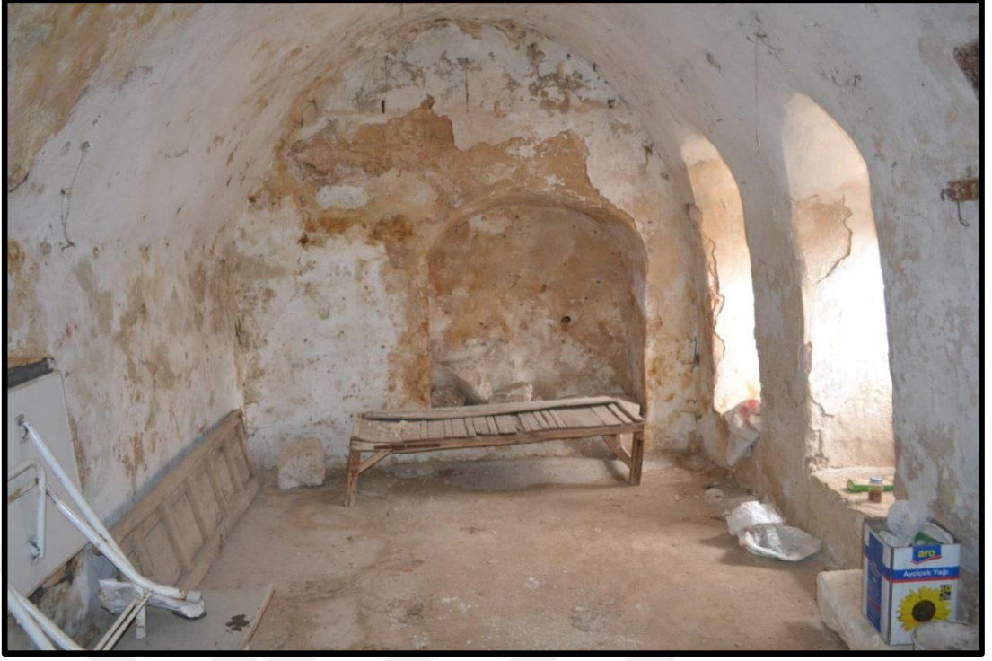
Şekil 33. Sıcak ve soğuk havadan korunmak için yapılmış kalın duvarlı bir oda.
