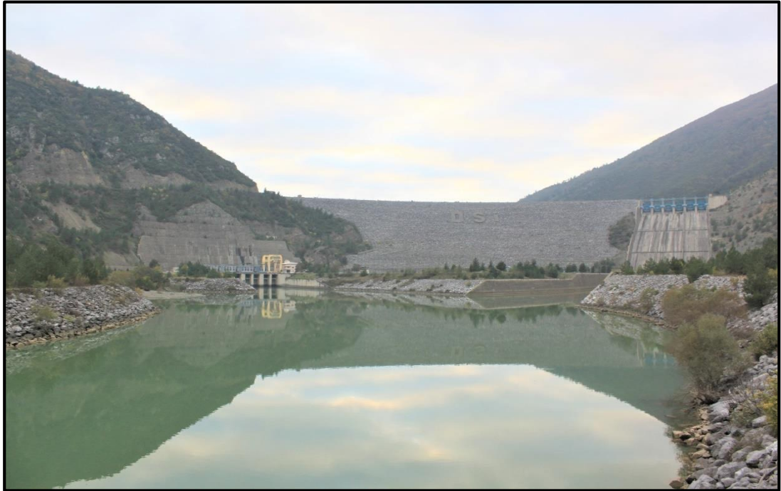
Şekil 40: Altınkaya Barajı ve HES'nin ağız kısmının kuzeyden görünüşü
