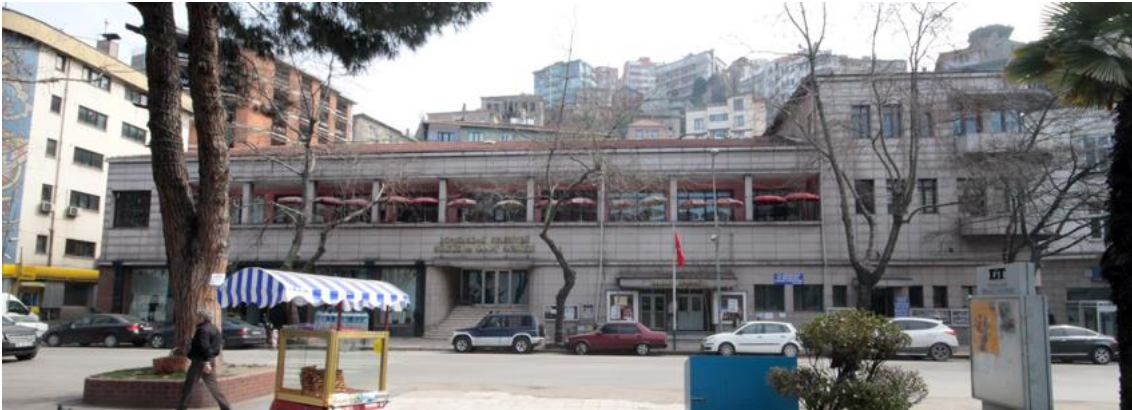
F. 122. Zonguldak Halkevi binası güncel durumunu gösteren batı cephesi fotoğrafı (26.03.2015)
