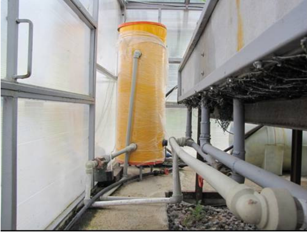
Şekil 3.1.2.1. 3. Köklendirme serası ısı ünitesi
