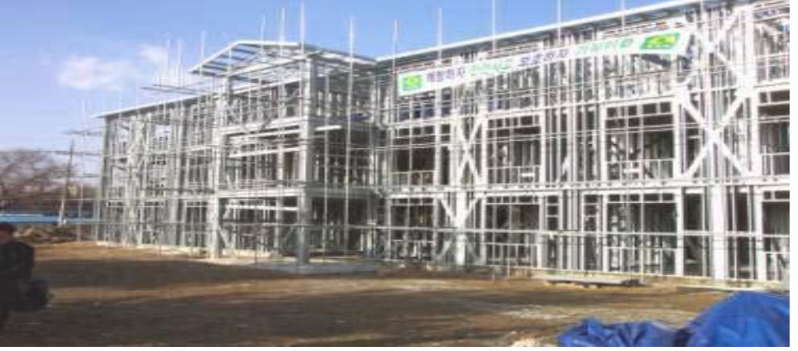
Şekil-2.25: Dış duvar karkası
