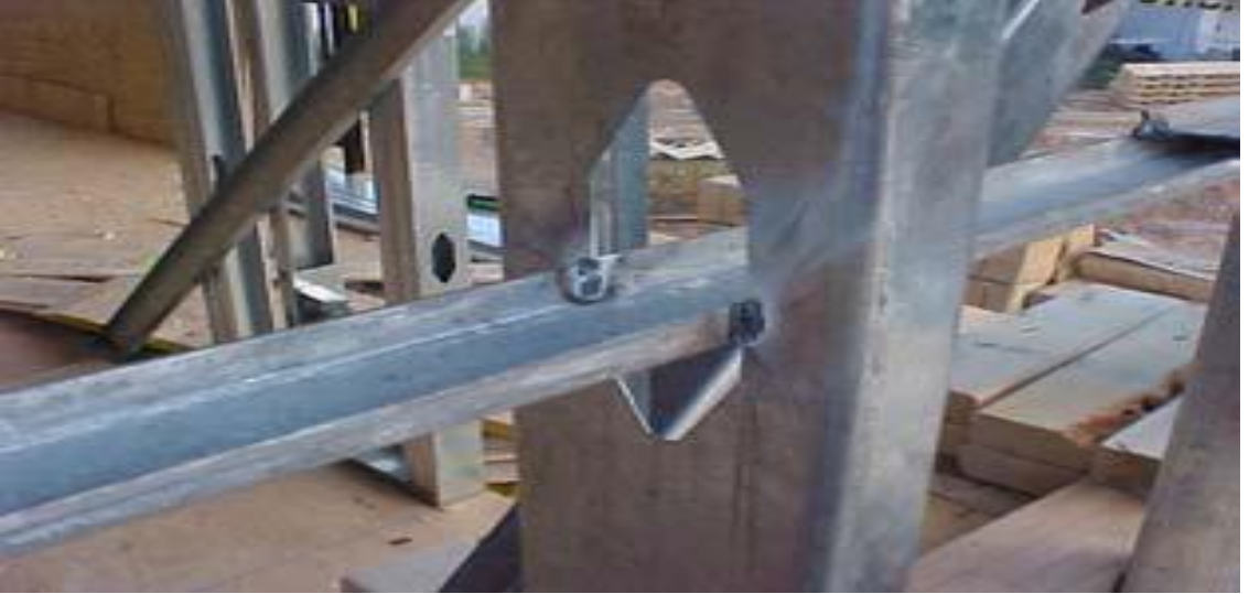
Şekil-2.18: İç duvar uygulaması shaft geçişi
