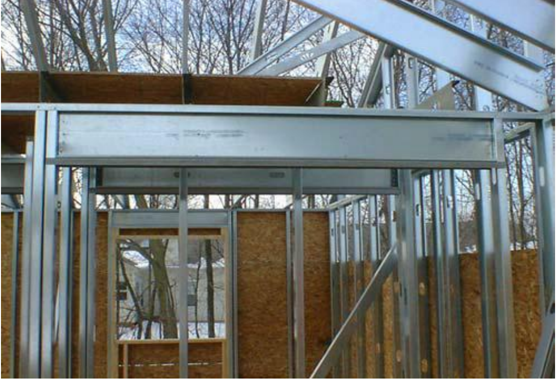
Şekil-2.19: İç duvar üstü kiriş uygulaması
