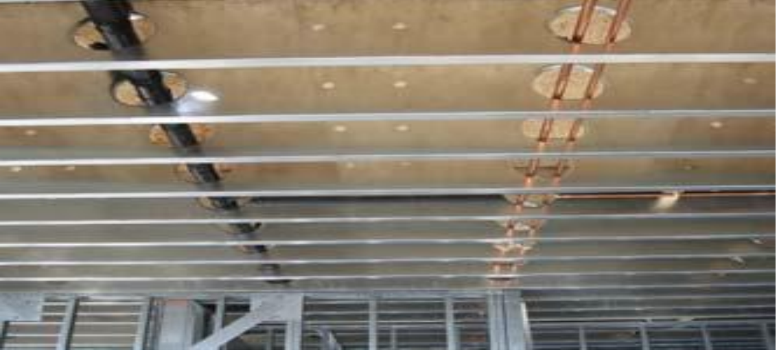
Şekil-2.21: Arakat döşeme karkası tesisatın geçişi
