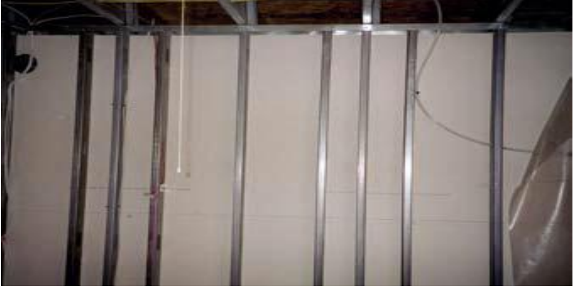
Şekil-2.17: İç duvar uygulaması
