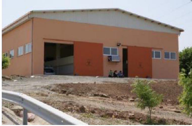
Şekil 3.7. Samsun Büyükşehir Belediyesi Tıbbi Atık Sterilizasyon Tesisi. (SBB, 2011).
