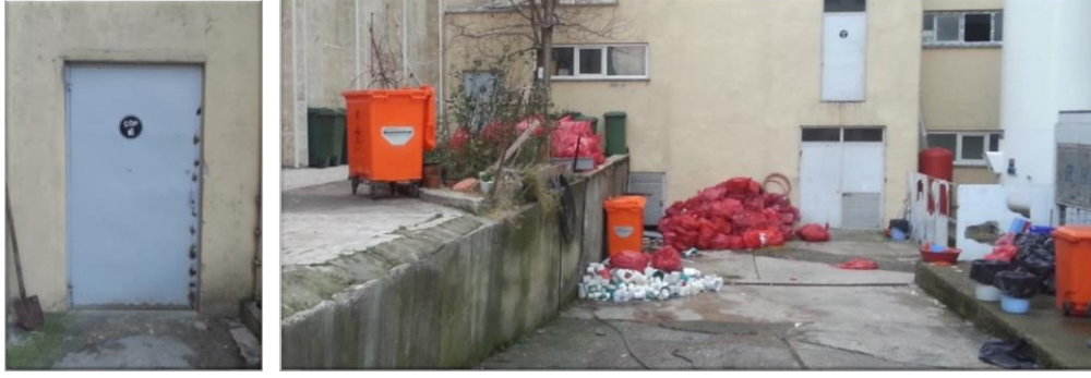
Şekil 4.33. Atık toplama deposu
