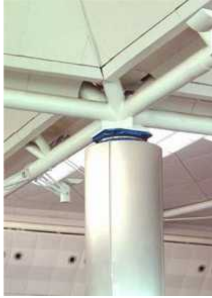
Resim 6.4. Atatürk Havalimanı çatısında kullanılan sürtünmeli sarkaç mesnet detayı [74]
