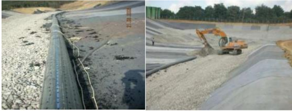
Şekil 2.18. Sızıntı suyu drenaj boru yerleştirilmesi ( http://www.csb.gov.tr , 09.04.2015)
