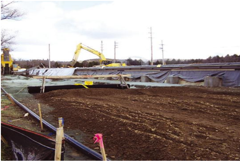
Şekil 2.10. Yaklaşık 305 m genişlikte yayılan Sr-90'ın arıtımı için trench-duvar inşaatı (Vandermeluen, 2012)
