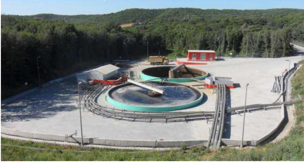
Şekil 2.19. Sızıntı suyu toplama havuzu ( http://www.csb.gov.tr , 09.04.2015)
