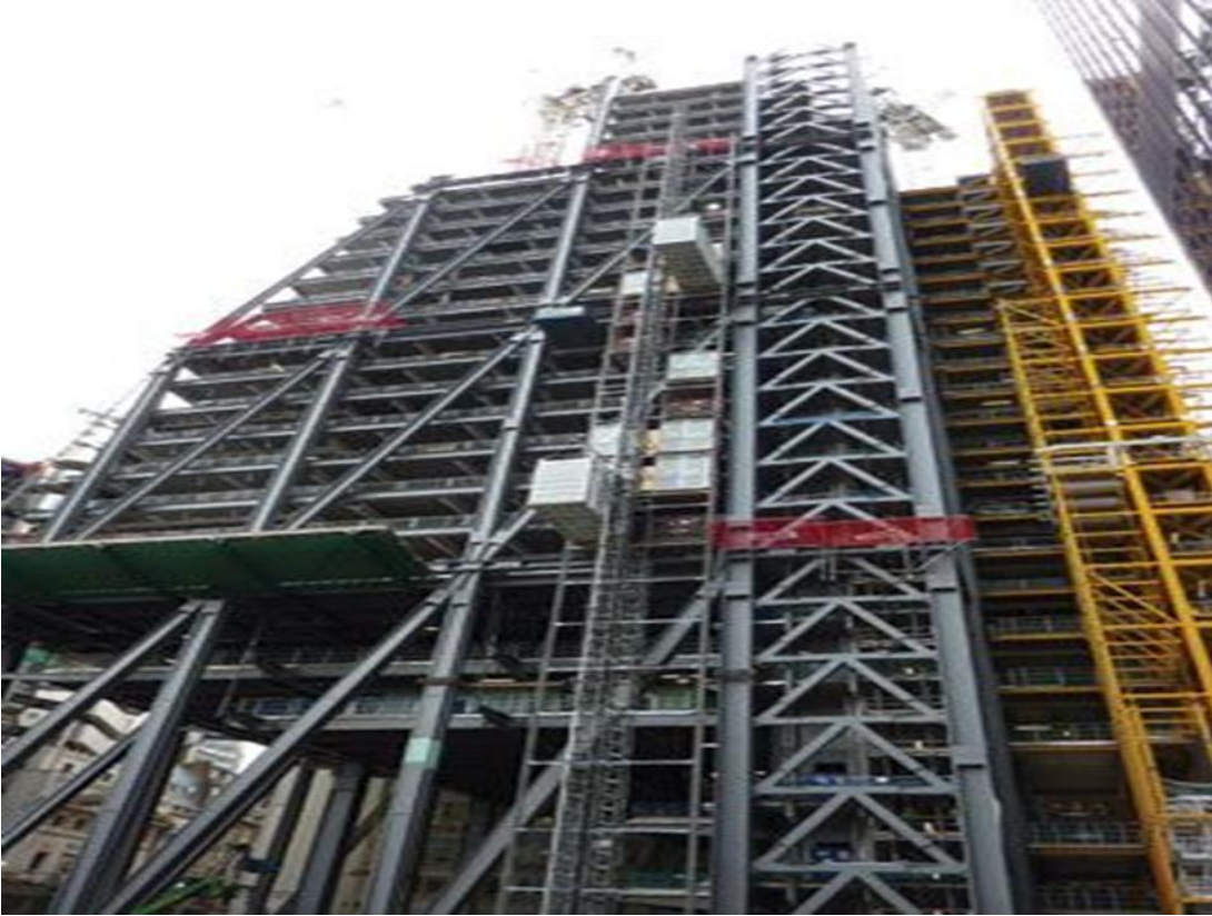
Şekil 4.12. Ters V tipi ve Diyagonal çelik çapraz uygulama örneği
