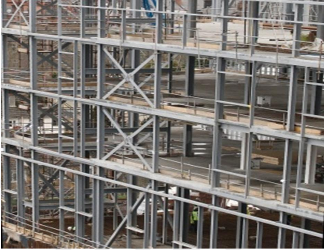
Şekil 4.9. X tipi çelik çapraz uygulama örneği
