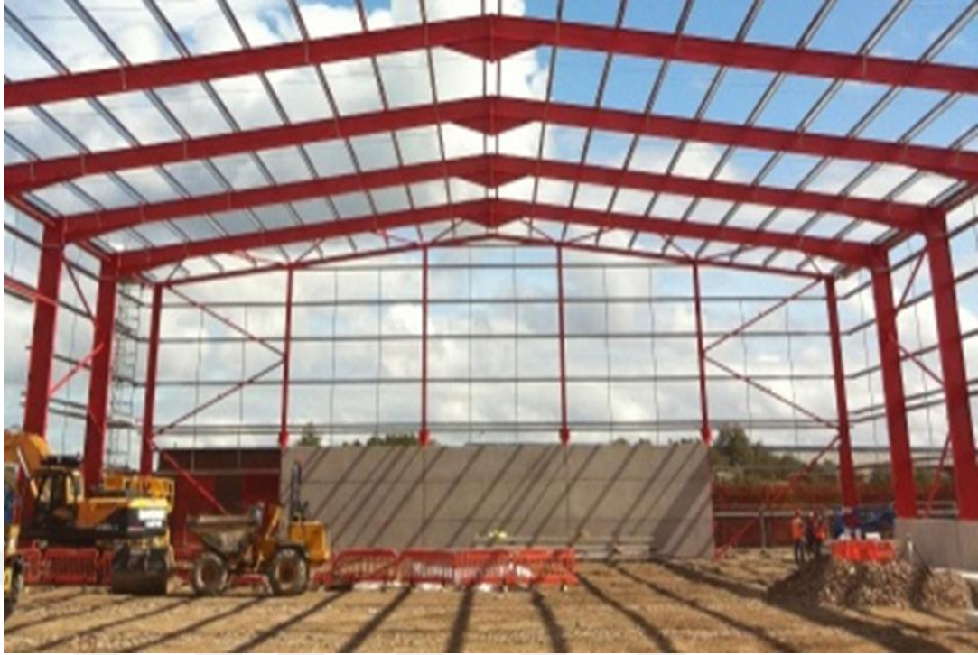
Şekil 4.13. K tipi çelik çapraz uygulama örneği
