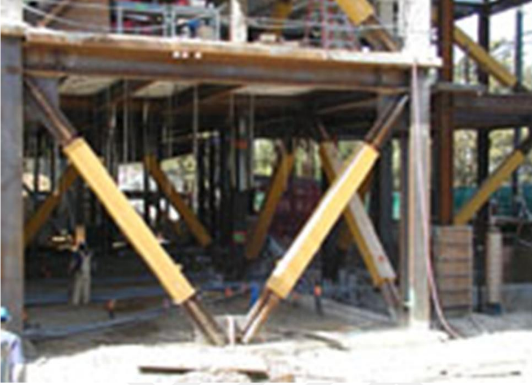
Şekil 4.11. V tipi çelik çapraz uygulama örneği
