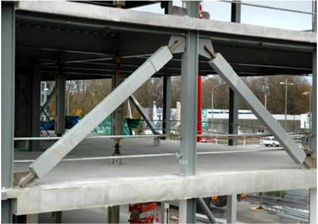
Şekil 4.10. Diyagonal çelik çapraz uygulama örneği
