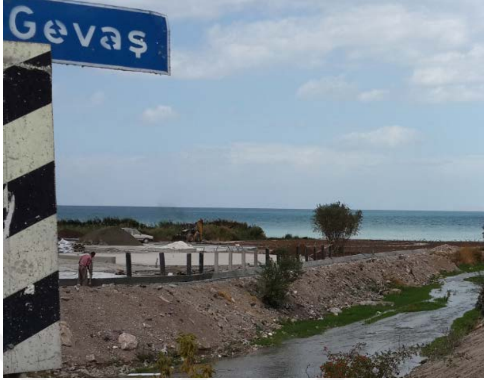
Şekil 4.4. Gevaş Deresi kenarında inşaat çalışmaları (22.09.2016)
