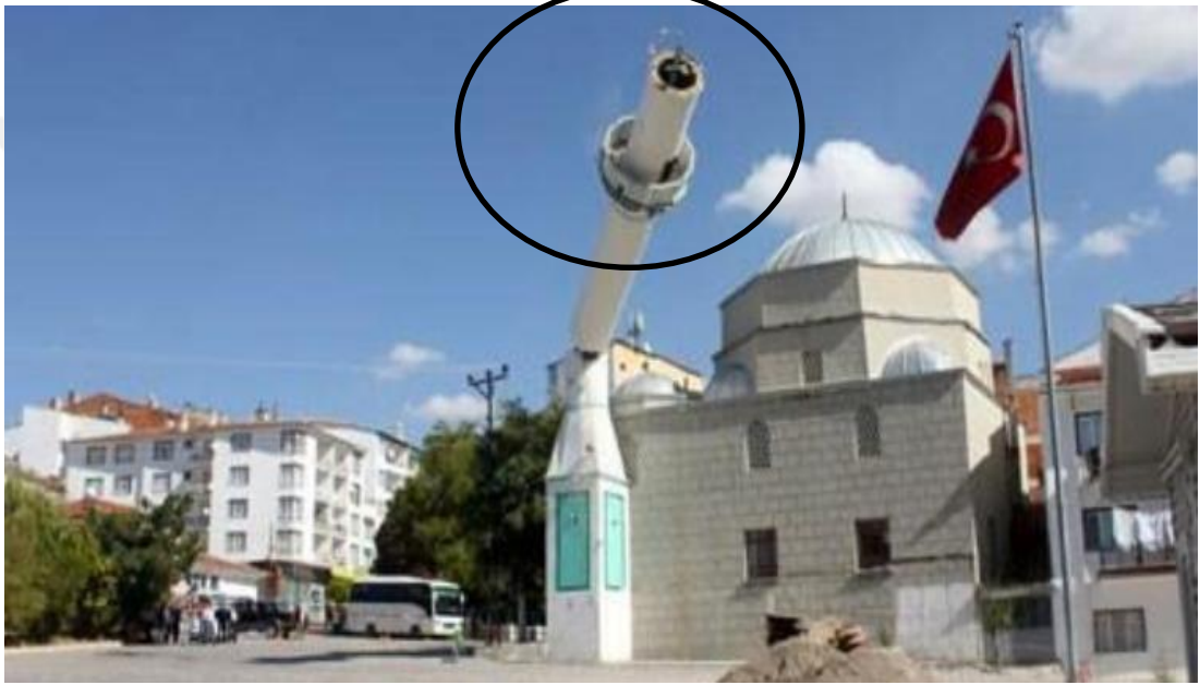
Şekil 1.15. Haymana’da şiddetli rüzgar nedeniyle lojmanın üzerine devrilen minare (Anonim, 2014)
