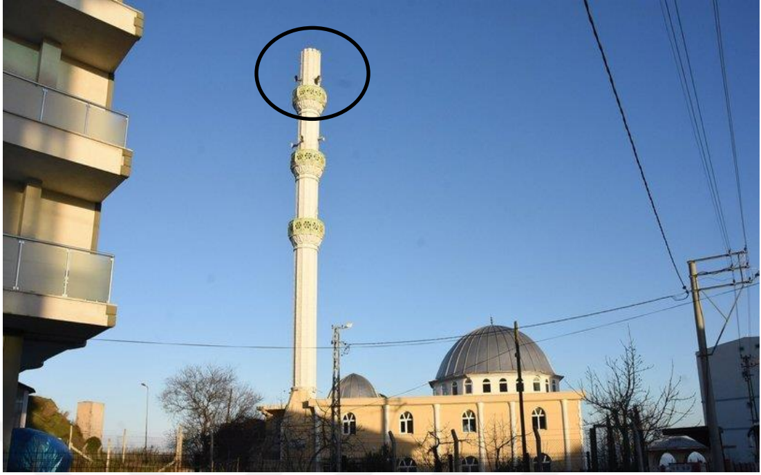
Şekil 1.19. Sinop'ta şiddetli fırtına nedeniyle yıkılan minare (Anonim, 2019)
