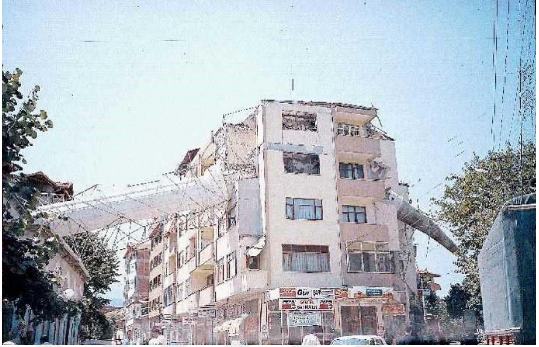
Şekil 1.4. Marmara depremi esnasında yıkılan minarenin binayı kılıç gibi kesmesi
