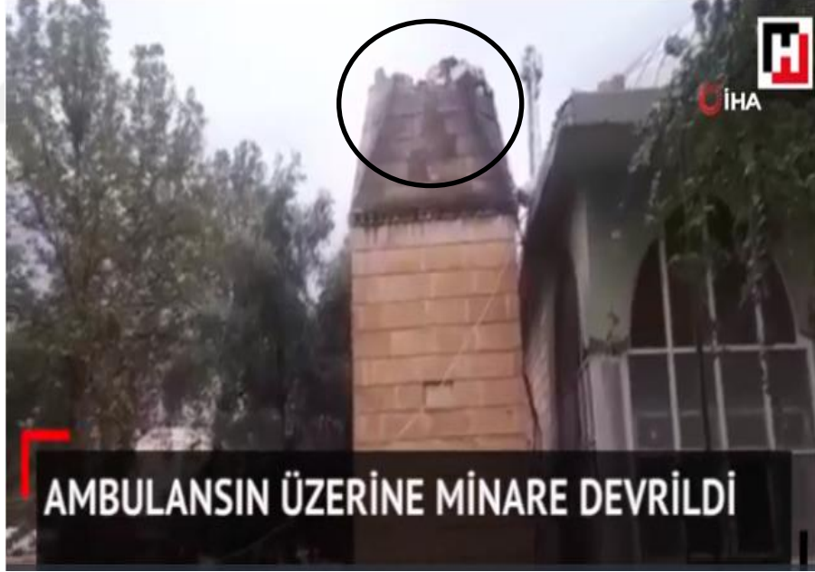
Şekil 1.18. Adıyaman’da şiddetli rüzgar nedeniyle yıkılan minare (Anonim, 2018)
