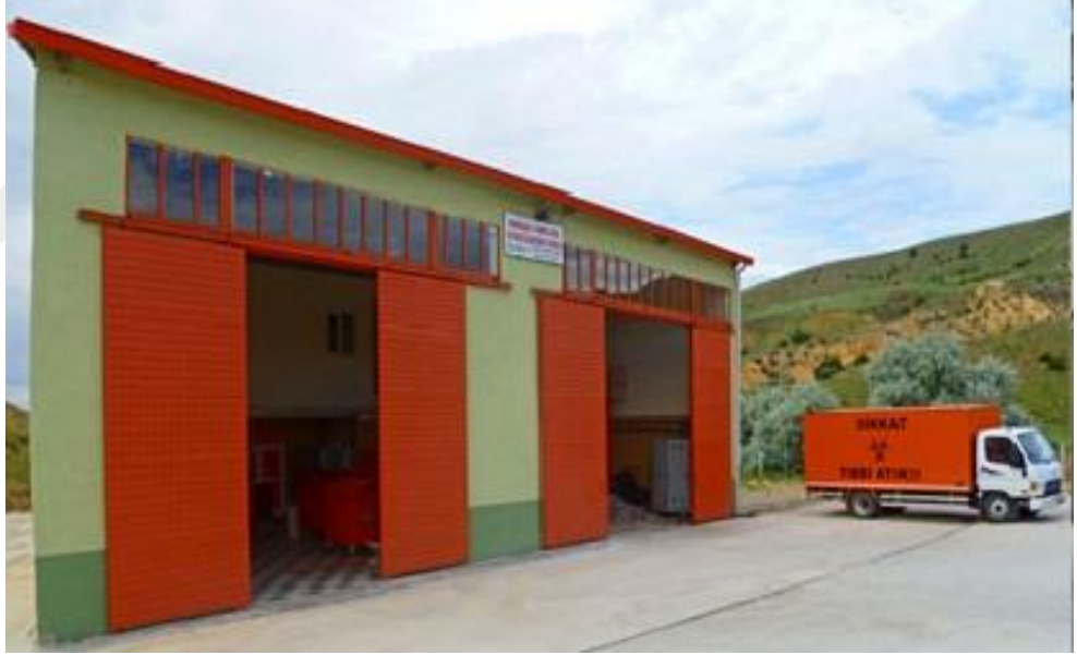
Şekil 3.3. Kırıkkale ili tıbbi atık sterilizasyon tesisi.
