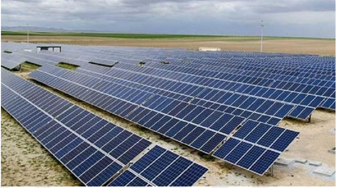
Şekil 2.5 Şebeke bağlantılı fotovoltaik sistem( http://www.yegm.gov.tr/ )
