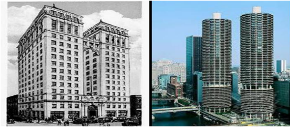
Şekil 4.3. Hafif beton kullanılarak inşa edilmiş yapı örnekleri 3 (solda Dallas Hilton Oteli, sağda Marina City Towers, Chicago –USA) (Kaldı, 2011)
