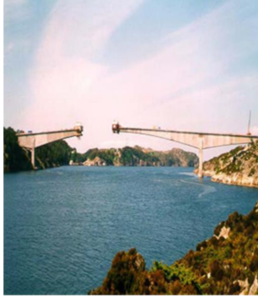
Şekil 4.10. Genleştirilmiş kil agregası ile inşa edilmiş köprü (Stolma Bridge) (Gönen, 2009)
