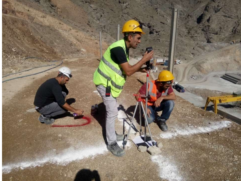
Şekil 3.8. Açık kazı çalışma sahası Leica Viva TS16 ile YKN ölçümü
