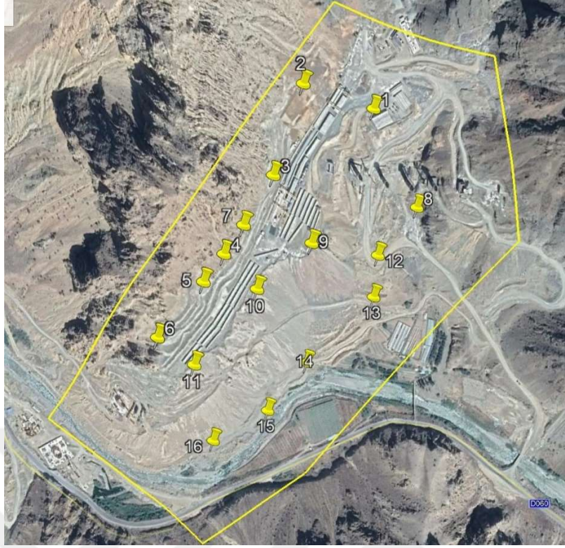
Şekil 3.7. Açık kazı çalışma sahası YKN dağılımı
