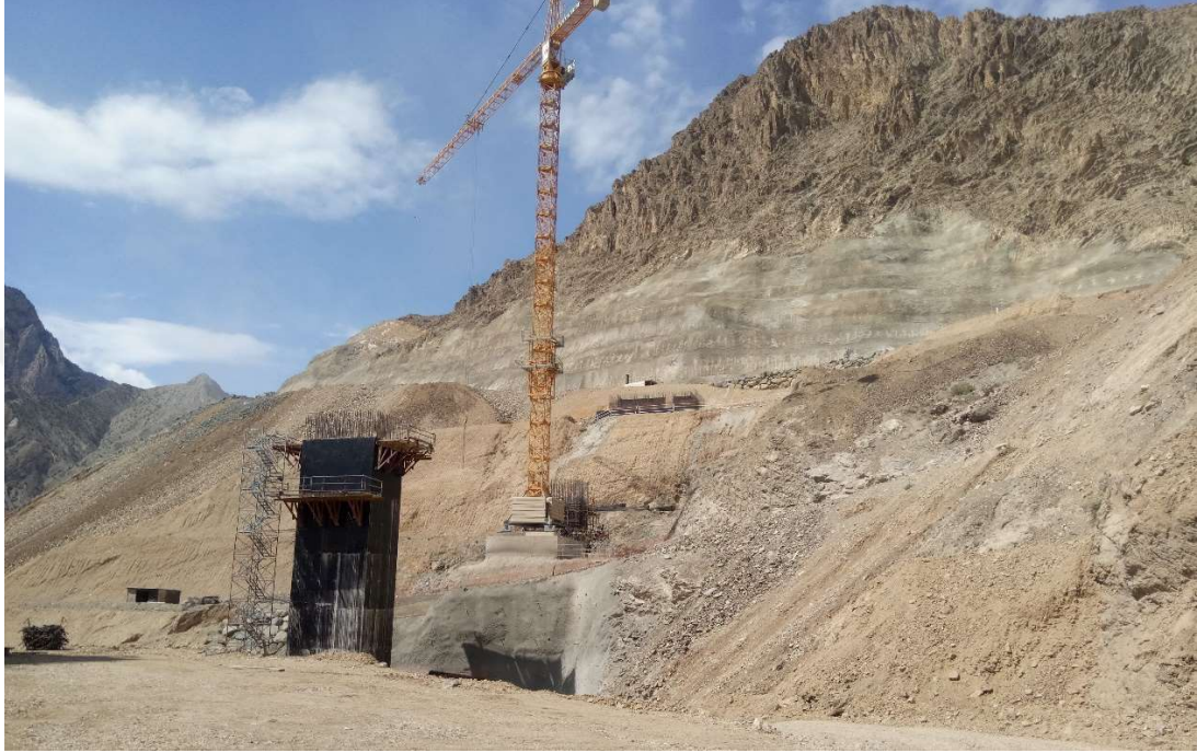
Şekil 3.2. Açık kazı çalışma sahası
