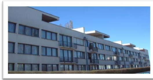
Şekil: 42. Ludwig Mies van der Rohe, Apartman, Weissenhof Yerleşkesi, Stuttgart, 1927. (www.google.com.tr)
