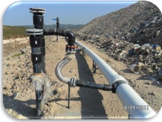
Şekil 3.6 Gaz Toplama Sisteminden Görüntü
