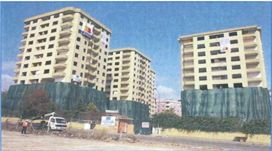
Şekil 14. Gaziosmanpaşa İlçesi, Sarıgöl Mahallesiinde Yıkım sonrası inşaat çalışmaları
