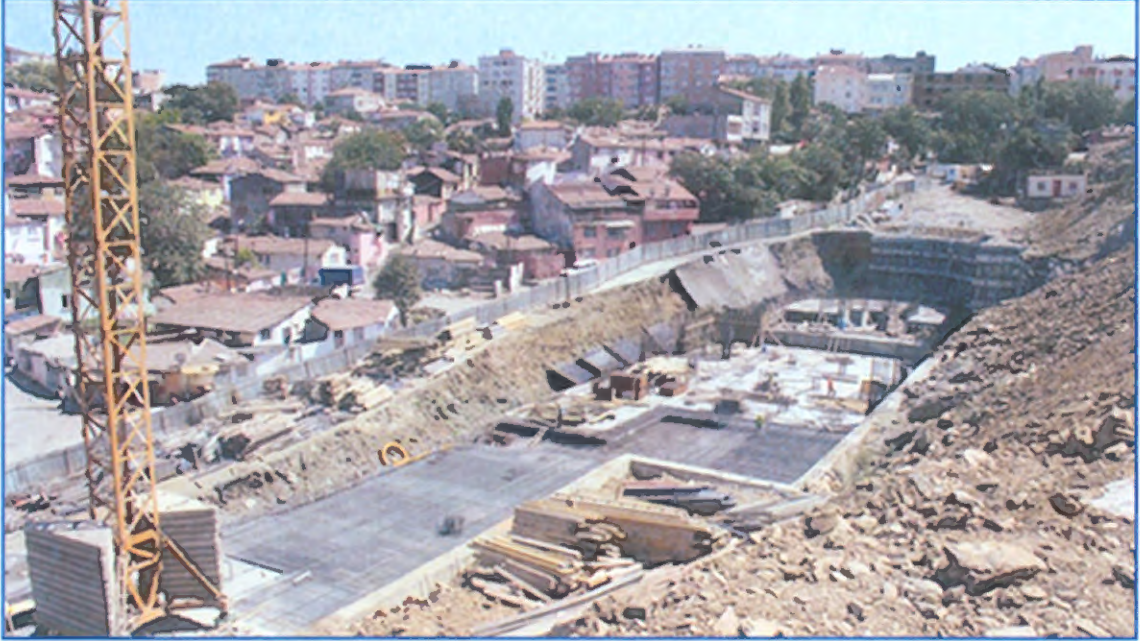
Şekil 13. Gaziosmanpaşa İlçesi, Sarıgöl Mahallesiinde Yıkım sonrası inşaat çalışmaları
