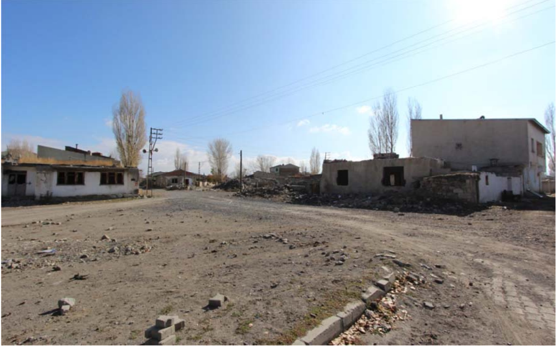
Şekil 4.78 Yeşilmahalle yıkım sonrası bir görüntü
