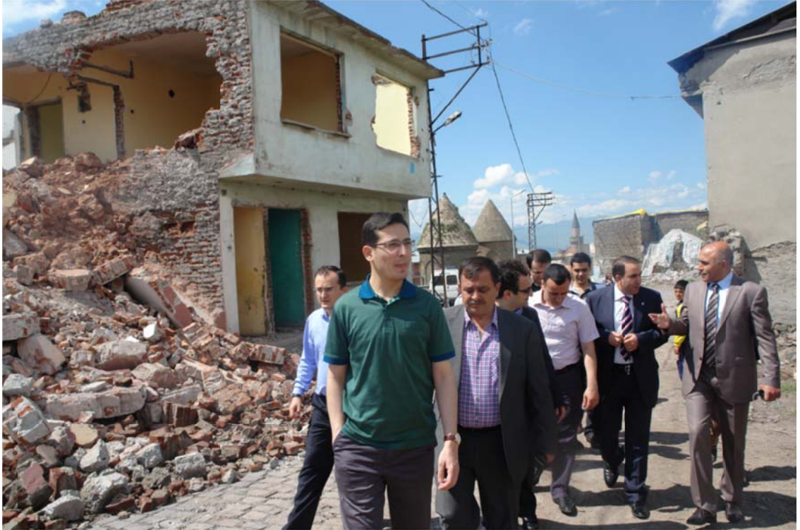
Şekil 4.26 Üç Kumbetler Yıkım Çalışmalarından Bir Görüntü
