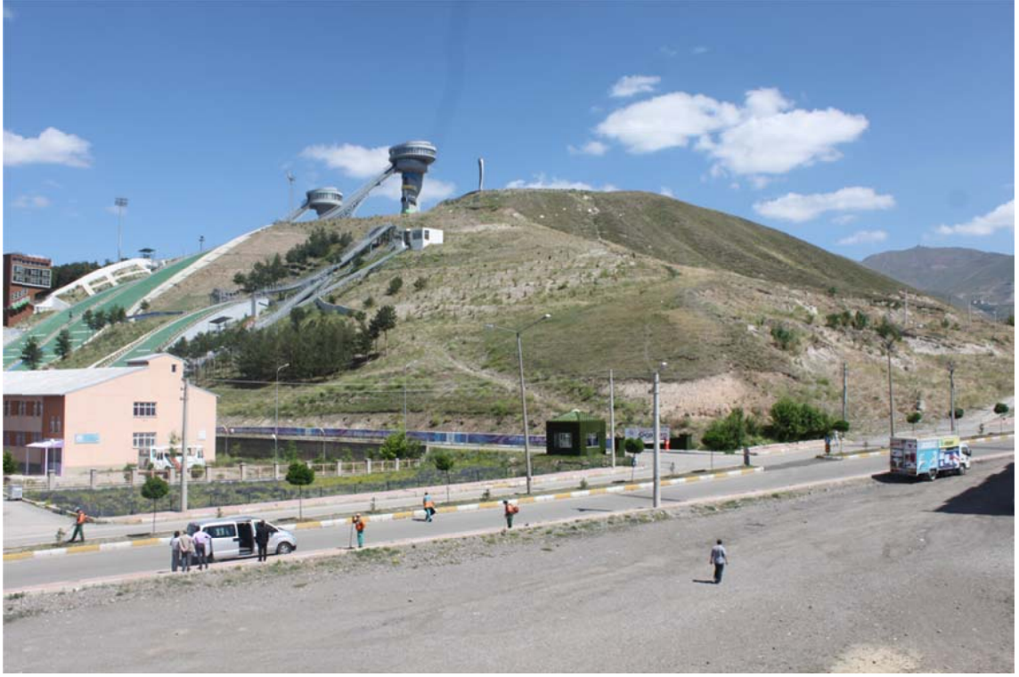
Şekil 4.41 Harput Mahallesi Yıkım Sonrasına Ait Görüntü
