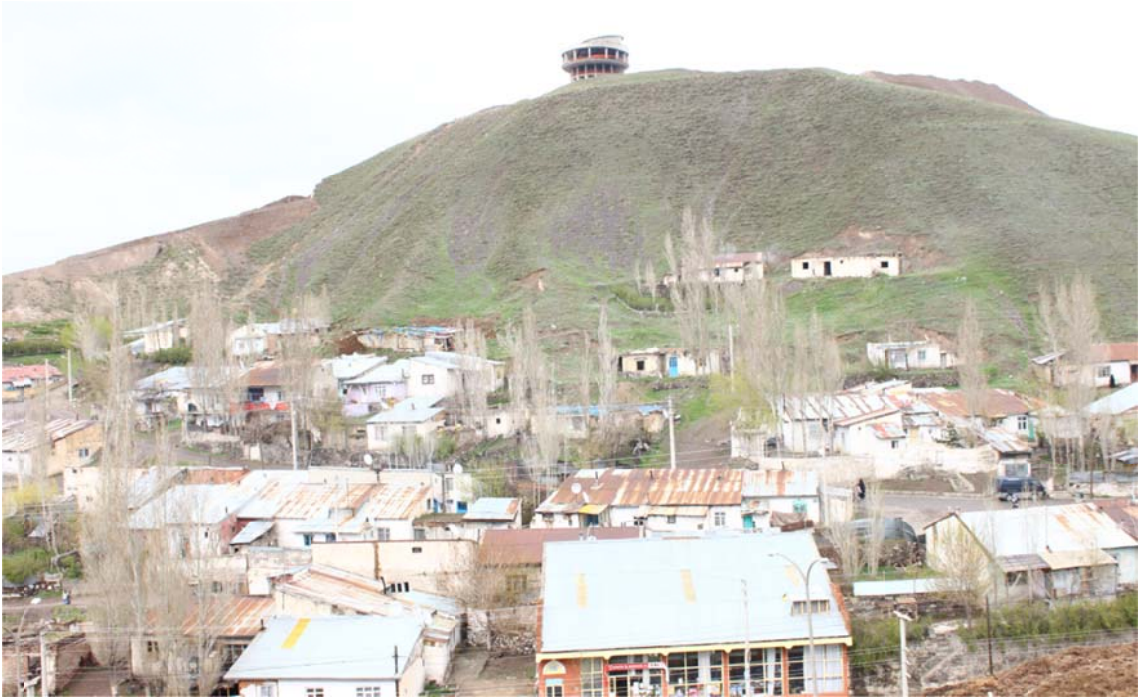
Şekil 4.36 Harput Mahallesi Dönüşüm Öncesine Ait Görüntü
