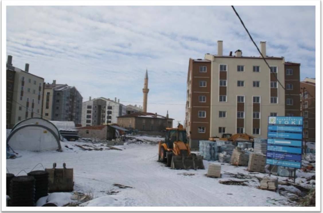
Şekil 4.49 Dönüşüm Sonrasına Ait Görüntü (İnşaat çalışmaları devam ederken)
