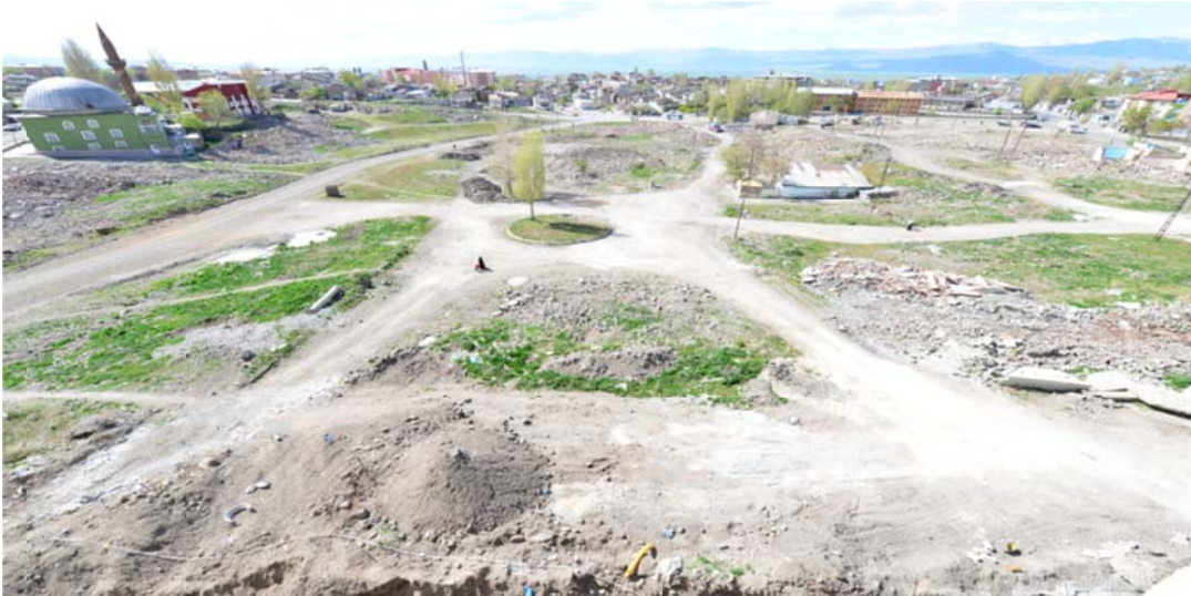
Şekil 4.29 Mehdiefendi Mahallesi Yıkım Çalışmaları Sonrası Bir Görüntü 115
