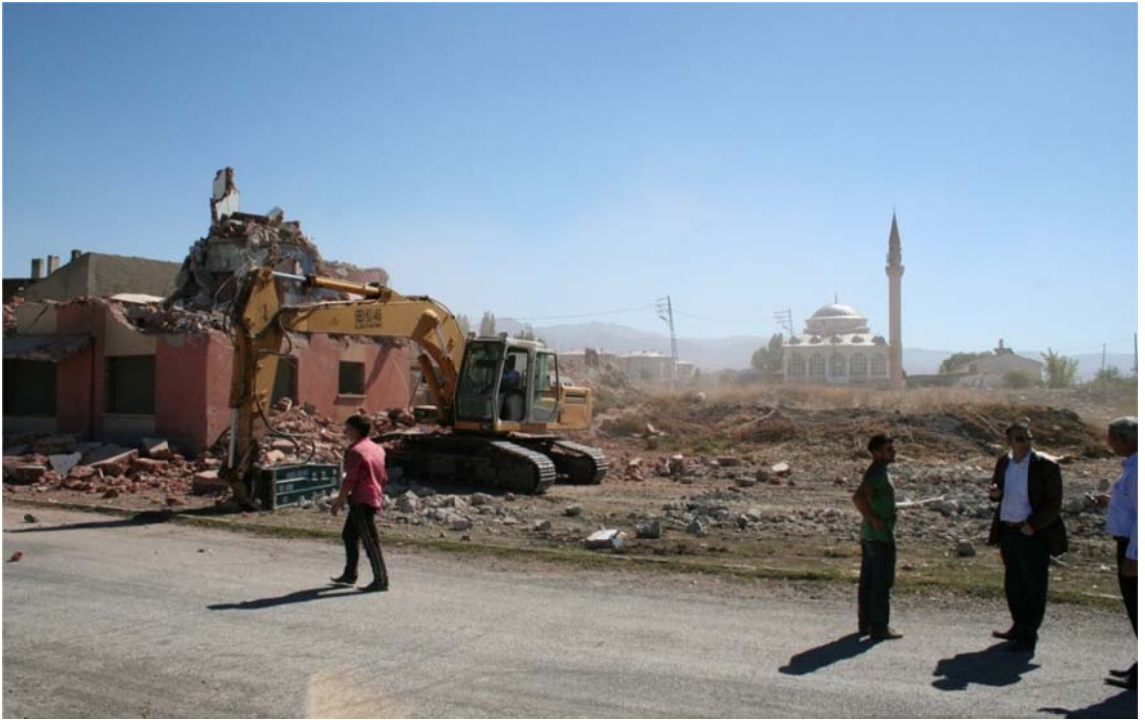
Şekil 4.68 Gezköyü Yıkım Çalışmalarından Bir Görüntü
