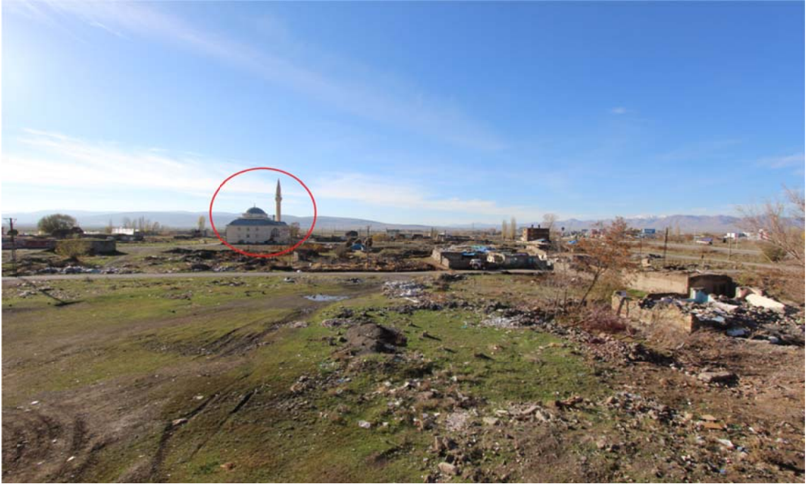
Şekil 4.70 Gezköyü Yıkım Sonrası Bir Görüntü
