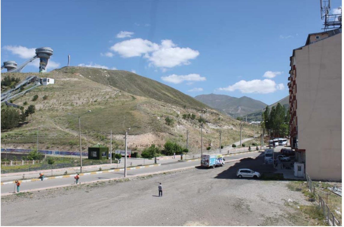
Şekil 4.40 Harput Mahallesi Yıkım Sonrasına Ait Görüntü
