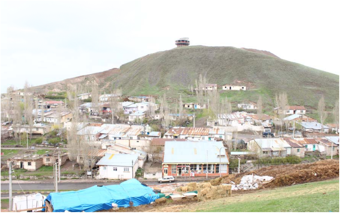
Şekil 4.35 Harput Mahallesi Dönüşüm Öncesine Ait Görüntü
