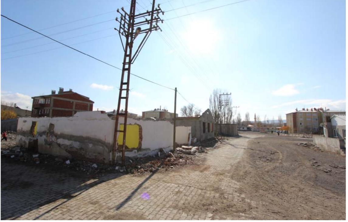
Şekil 4.80 Yeşilmahalle Yıkım sonrası Bir Görüntü
