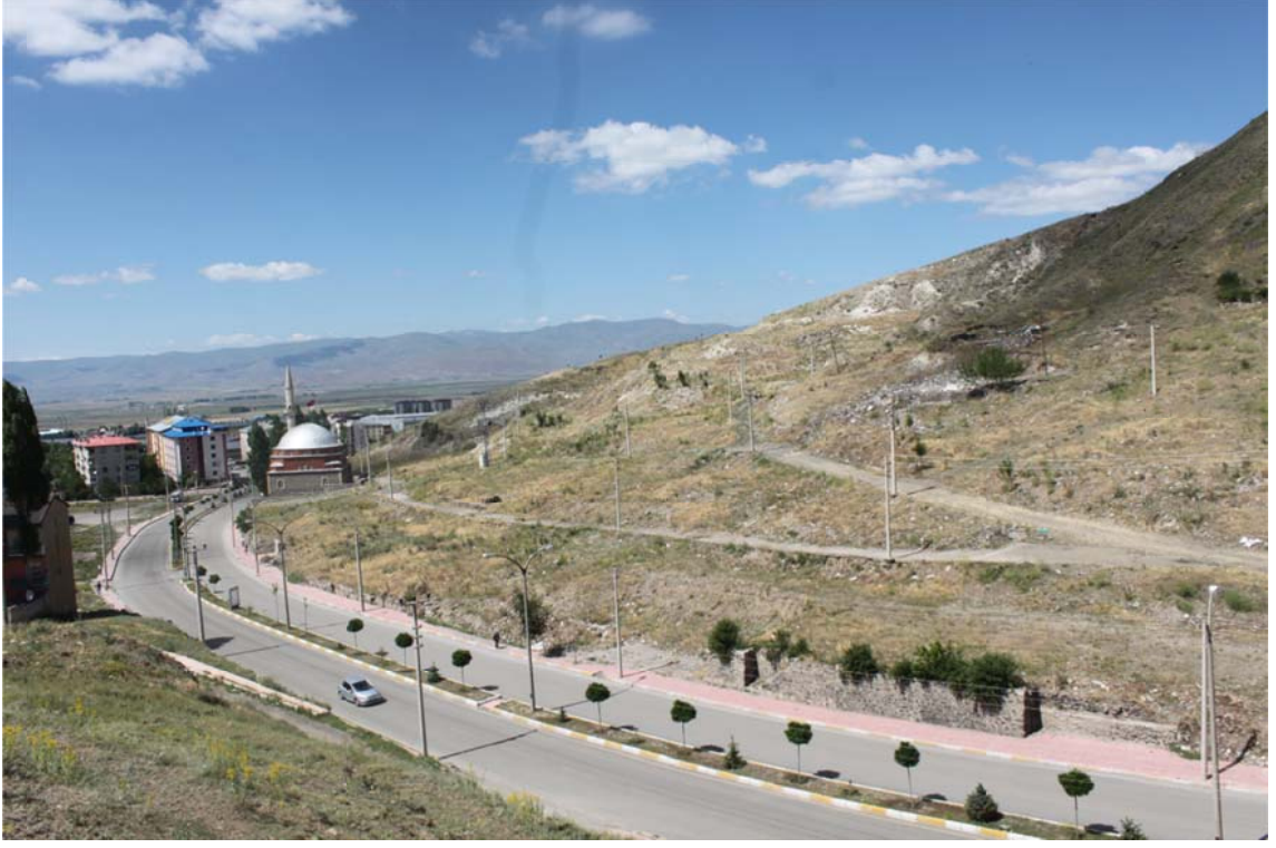
Şekil 4.39 Harput Mahallesi Yıkım Sonrasına Ait Görüntü
