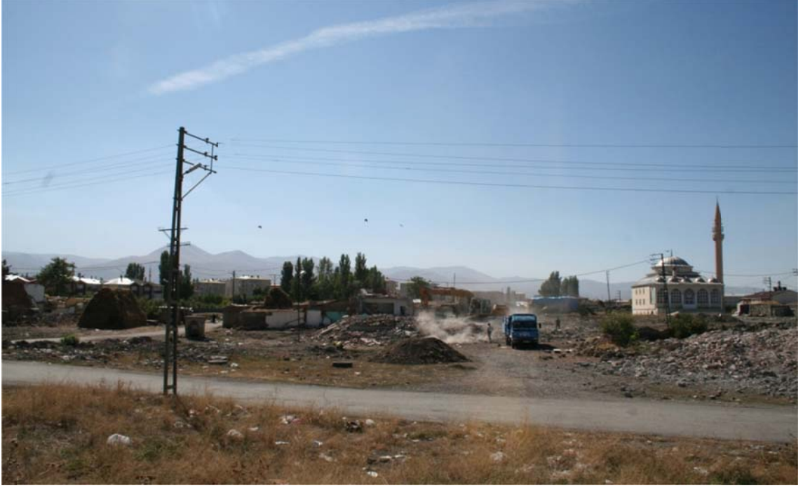
Şekil 4.67 Gezköyü Yıkım Çalışmalarından Bir Görüntü
