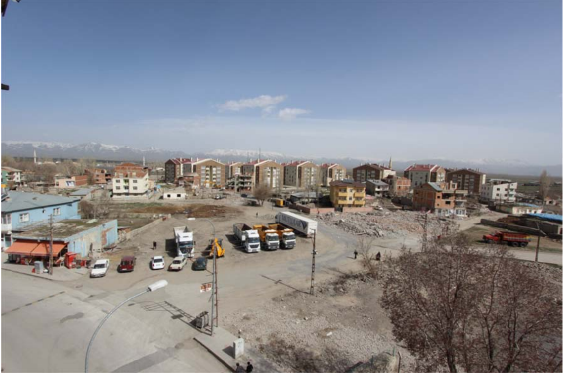
Şekil 4.62 Eski Mahalle 2.Etap Yıkım Sonrası
