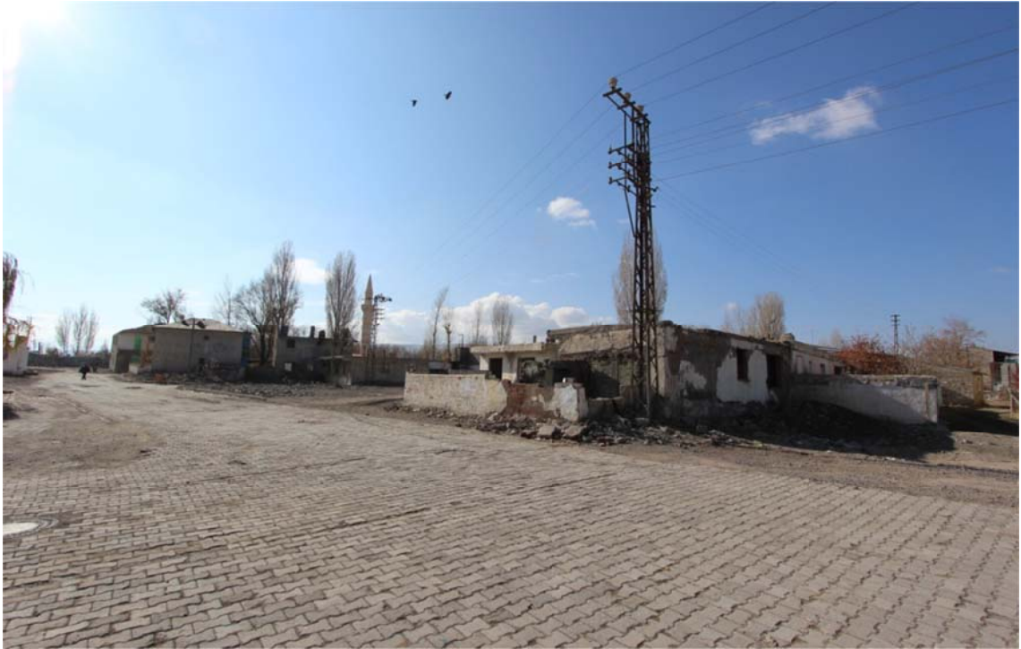
Şekil 4.79 Yeşilmahalle Yıkım Sonrası Bir Görüntü
