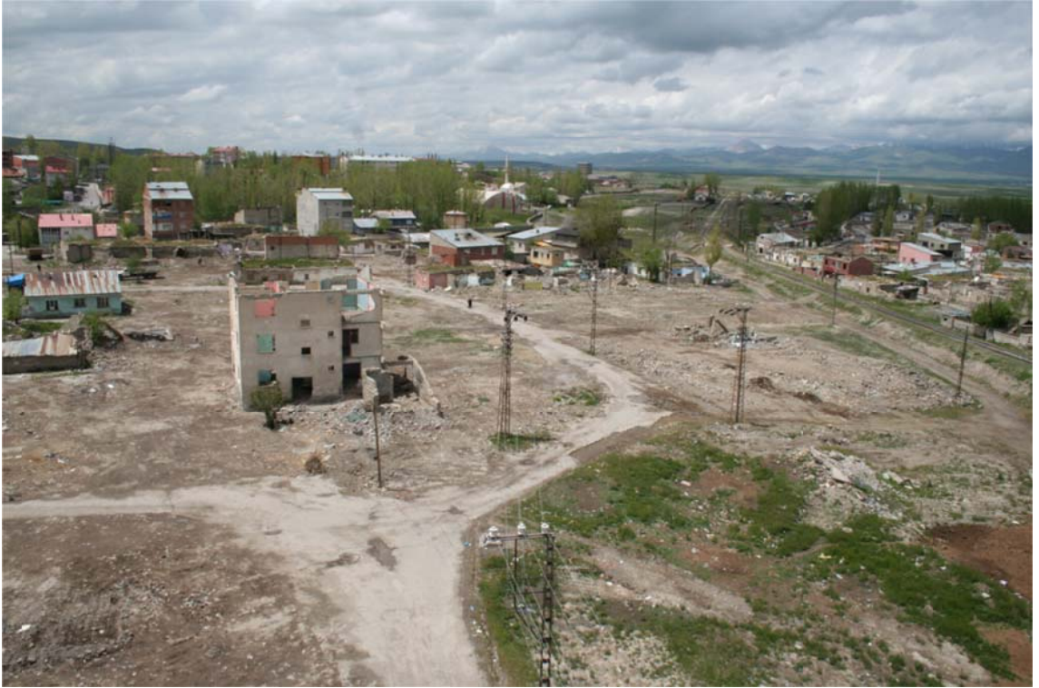
Şekil 4.63 Eski Mahalle 2.Etap Yıkım Sonrası
