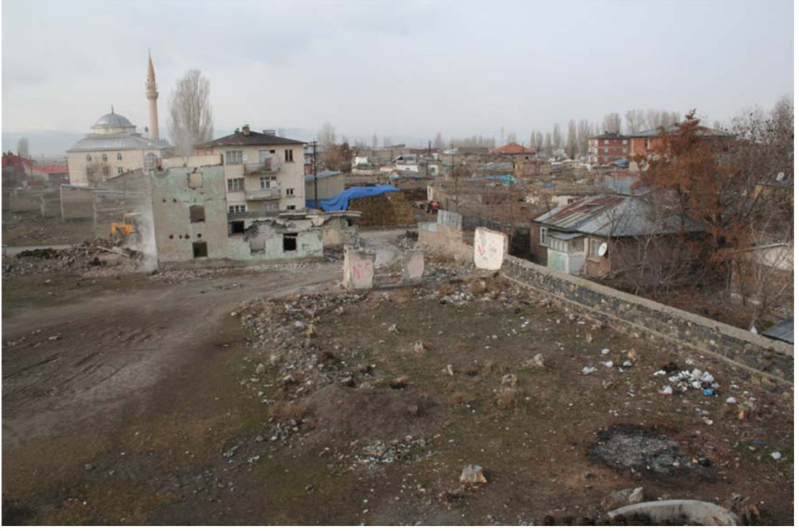
Şekil 4.69 Gezköyü Yıkım Sonrası Bir Görüntü
