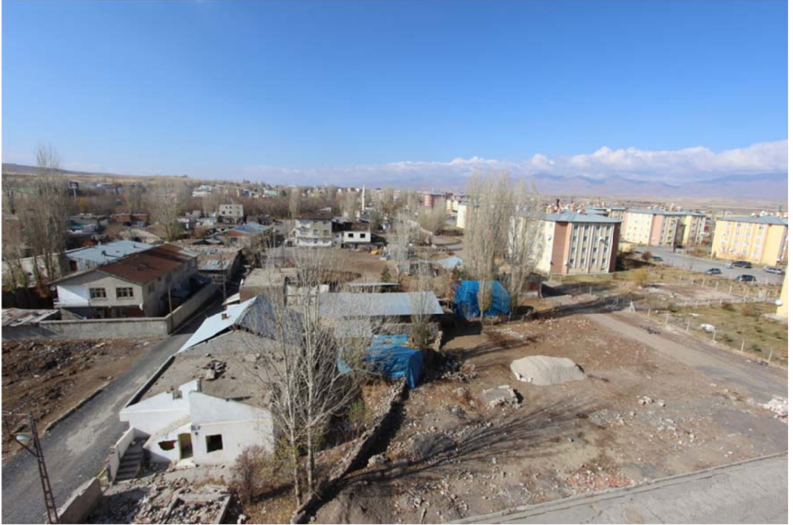
Şekil 4.81 Yeşilmahalle Yıkım Sonrası Bir Görüntü
