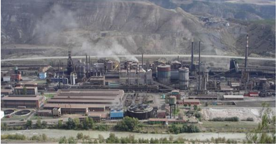
Şekil 2 1 Karabük Demir Çelik Tesisleri
