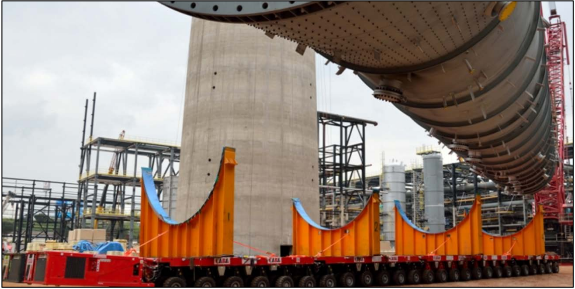
Şekil:6.1. Proje Taşımacılığında Montaj Sırasında Demonte Edilen Taşıyıcı Semerler. (Çaba-2014)
