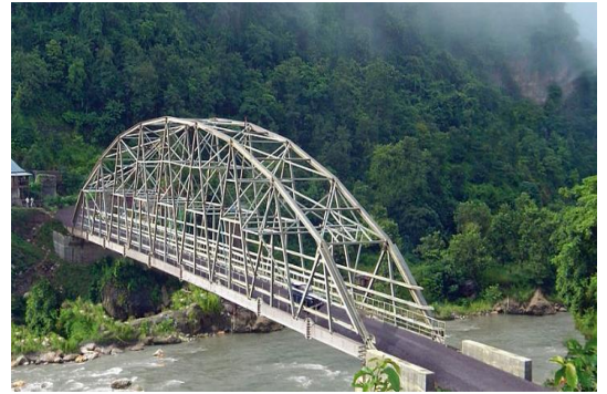
Şekil 3.2 Sulu açıklık üstüne inşa edilmiş çelik konstrüksiyonlu köprü.
