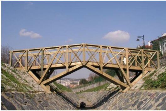
Şekil 3.1 Sulu açıklığı aşmak amacıyla yapılmış ahşap köprü.
