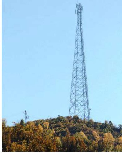
Şekil 4.13 M bölgesinde etkin çekim gücü bulunan GSM vericisine ait kafes tip direk.
