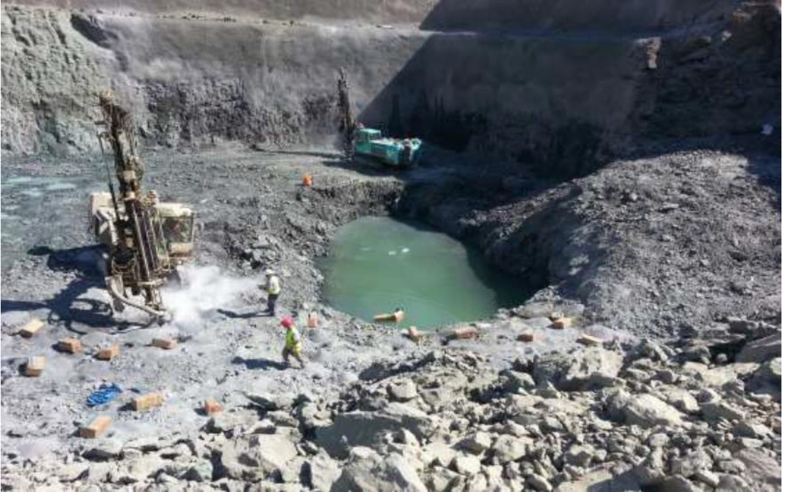
Resim 20. Ankraj bloğu Delgi Çalışmaları
