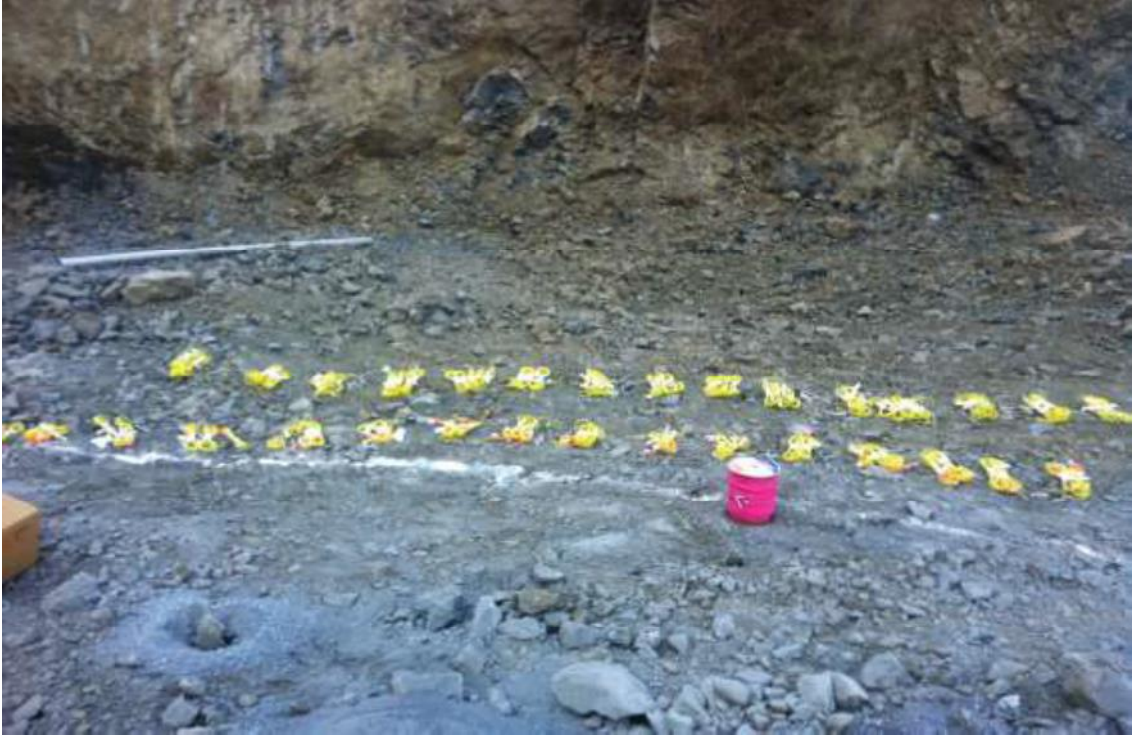
Resim 4. 3.Boğaz Köprü'sü Temel Şaftı Patlatması için hazırlık
