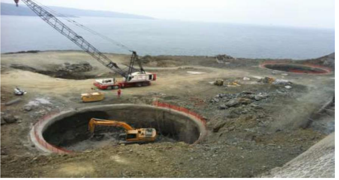
Resim 11. 3.Boğaz Köprü'sü Temel Şaftlarından genel bir görüntü.
