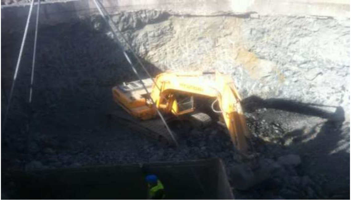
Resim 10. 3.Boğaz Köprü'sü Temel Şaftı Patlatma sonrası kazının dışarı çıkarılması.
