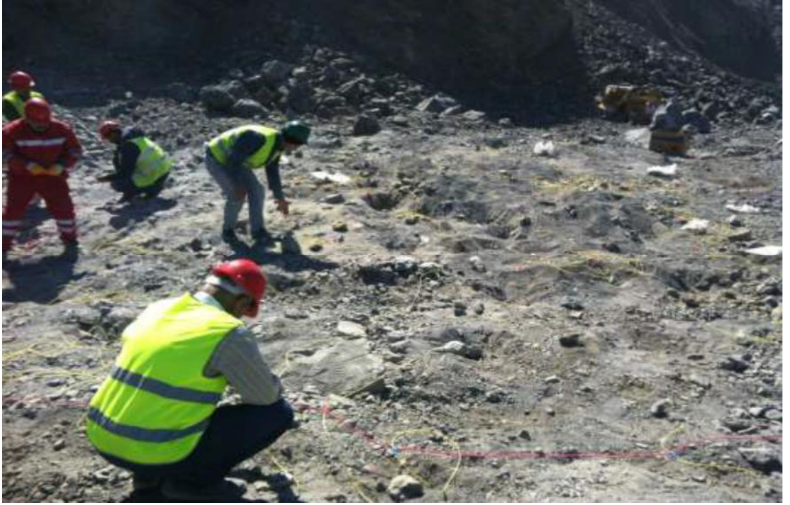
Resim 6. 3.Boğaz Köprü'sü Temel Şaftı Patlatması için bağlantı yapılması.
