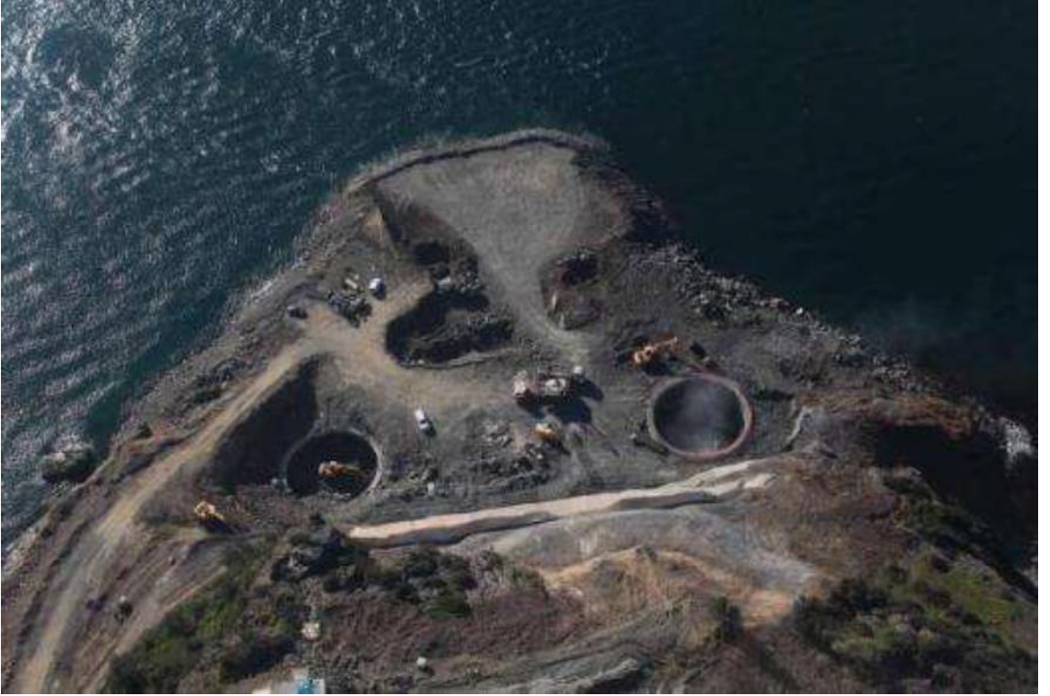
Resim 12. 3.Boğaz Köprü'sü Temel Şaftlarından genel bir görüntü.
