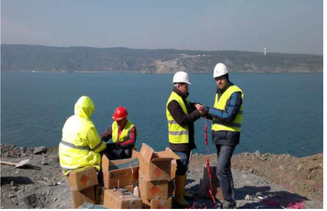
Resim 13. Ön kesme uygulamasında infilaklı fitile dinamitin bağlanması.
