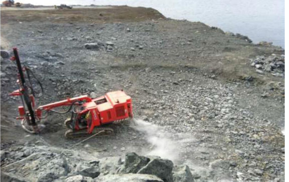
Resim 2. 3.Boğaz Köprü'sü Temel Şaftı Hat delme işlemi.
