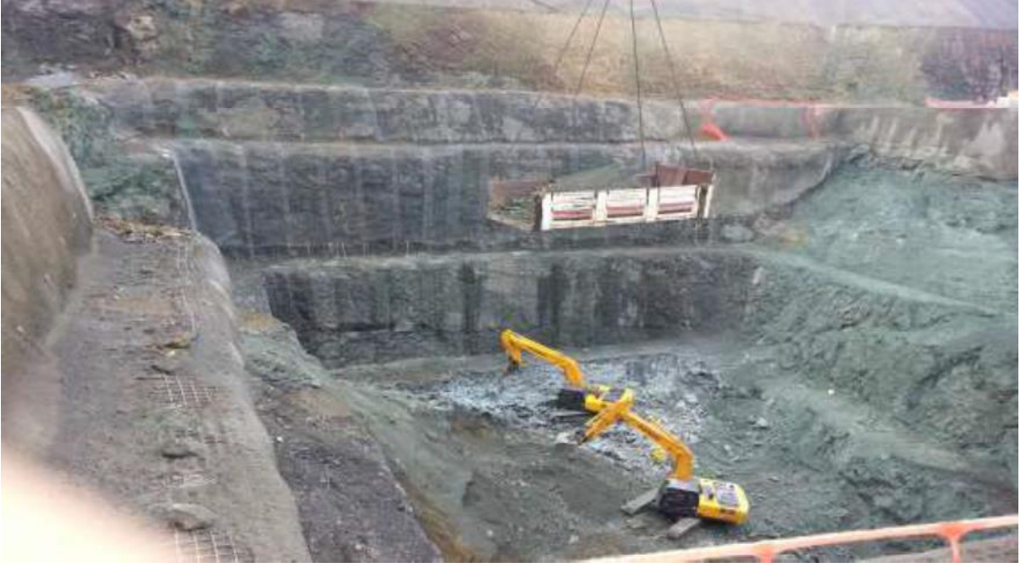
Resim 21. Patlatma sonrası yükleme çalışmaları
