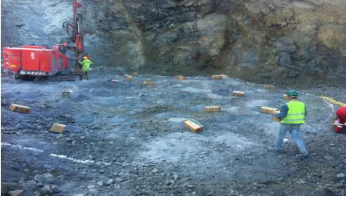
Resim 3. 3.Boğaz Köprü'sü Temel Şaftı Patlatması için hazırlık.
