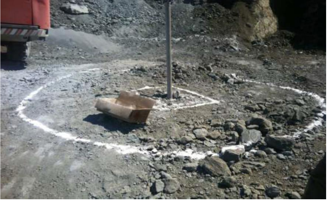
Resim 1. 3.Boğaz Köprü'sü Temel Şaftı Patlatma Paterni uygulama detayı.
