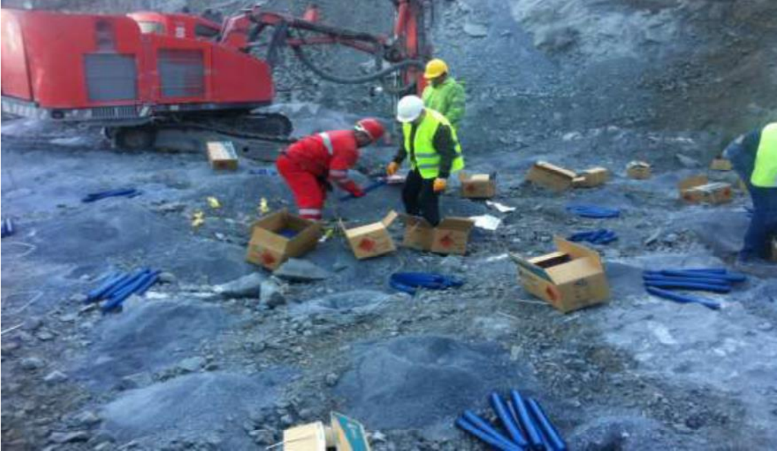
Resim 5. 3.Boğaz Köprü'sü Temel Şaftı Patlatması için Şarjlama.
