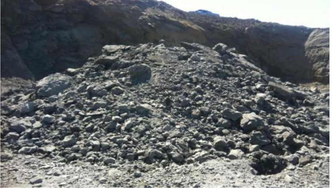
Resim 7. 3.Boğaz Köprü'sü Temel Şaftı Patlatma sonrası yığın görüntüsü.
