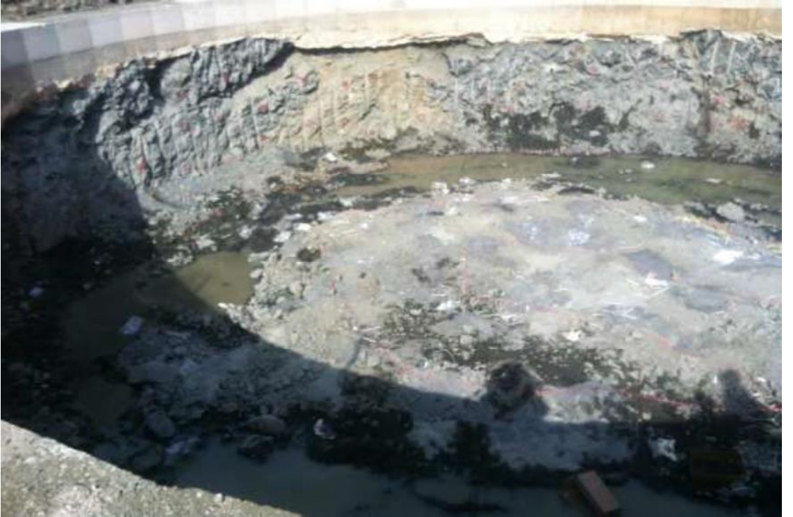
Resim 8. 3.Boğaz Köprü'sü Temel Şaftı Patlatma sonrası bir görüntü.
