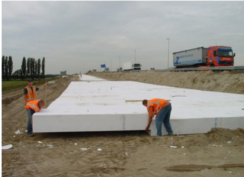
Şekil 1.1 A-15 Nolu Otoyolda Geofoam Bloklar Kullanılarak Yapılan Şerit Genişletme Çalışması, Hollanda (EUMEPS, 2010)
