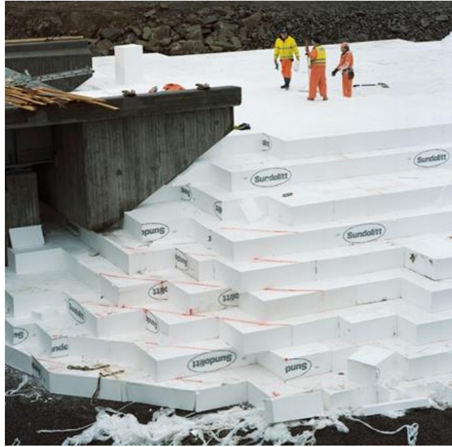
Şekil 3.2 Oslo -Goteborg Hogdalsbacken Köprüsü Yaklaşım Dolgusu (EUMEPS, 2010)
