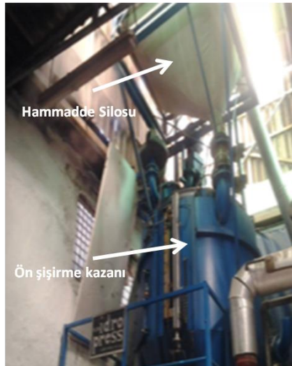
(a) EPS Hammaddenin hammadde silosundan ön şişirme makinesine dökülmesi
