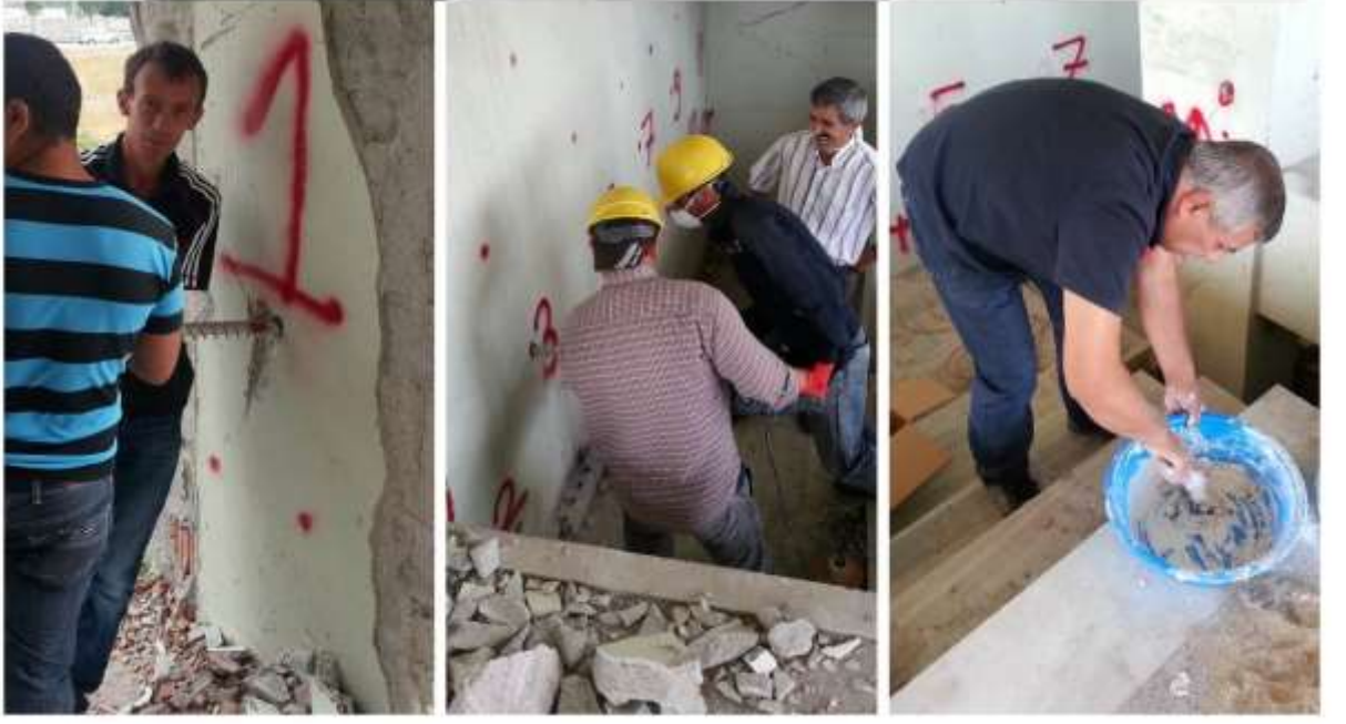
Şekil 4.6. Delik Delme ve Deliklerin Doldurulması Sırasında Çekilmiş Fotoğraflar
