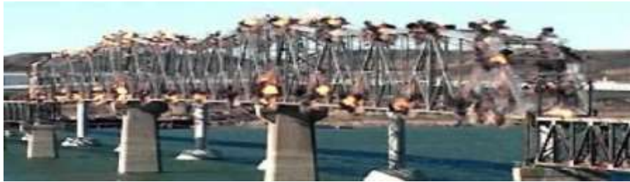
Şekil 2.18: Çelik Köprülerin Kontrollü Patlatmalarla Yıkılması (Özer ve Karadoğan, 2012)
