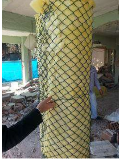
Şekil 2.25: Cam Yününün Gürültüyü Azaltmak Amacıyla Kolona Sarılması (Özyurt ve diğ., 2013-2)
