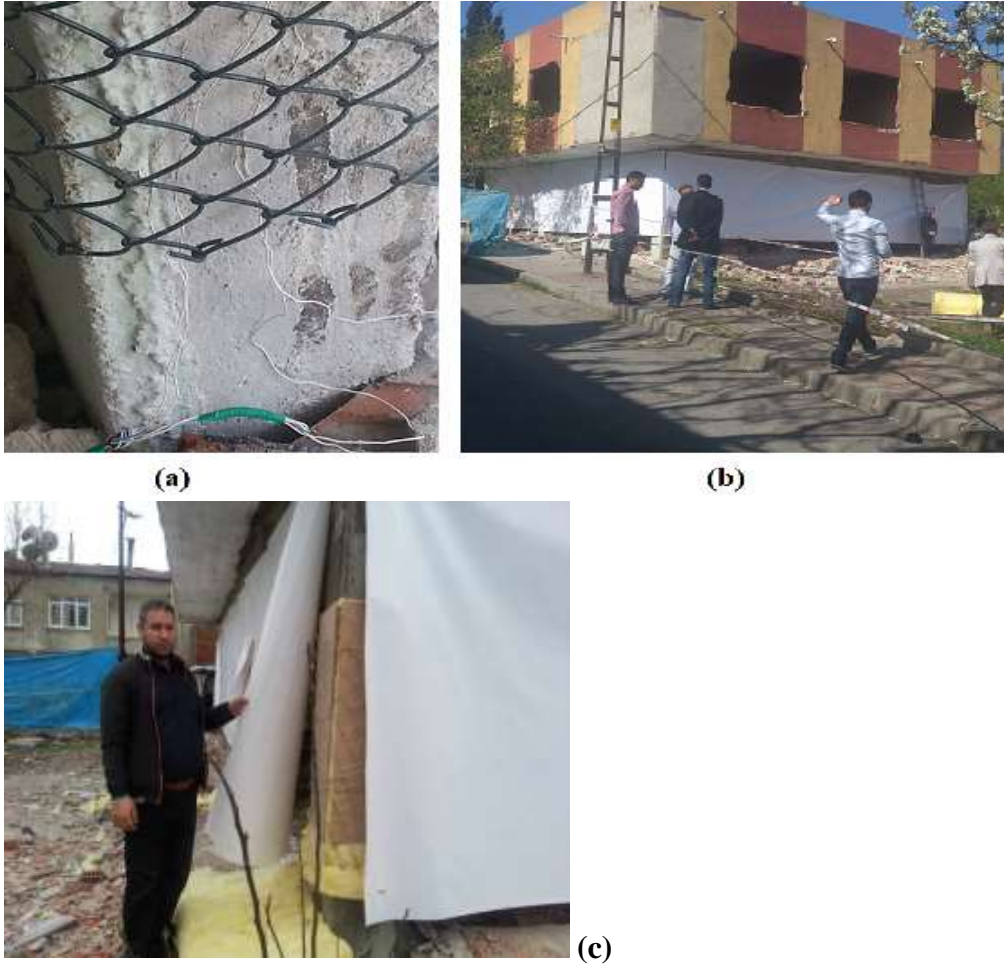
Şekil 2.24: Parça Savrulmasına Yönelik Alınan Güvenlik Önlemleri (Özyurt, 2013)
