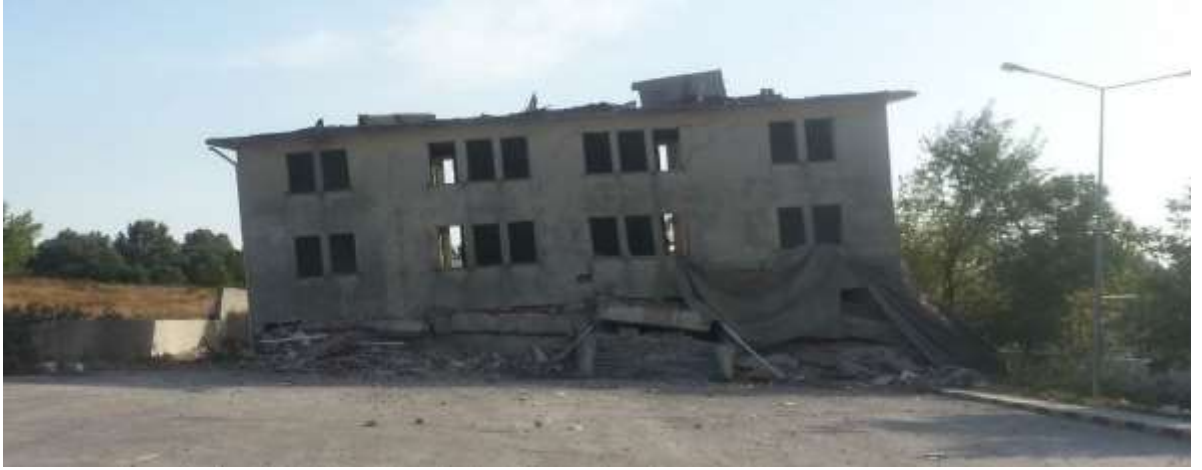
Şekil 4.11. Yıkım Tamamlandığında Binanın Durumu
