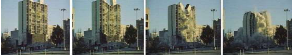
Şekil 2.10: Betonarme Binanın Olduğu Yere Çökertilerek Yıkılması (Özer ve Karadoğan, 2012)
