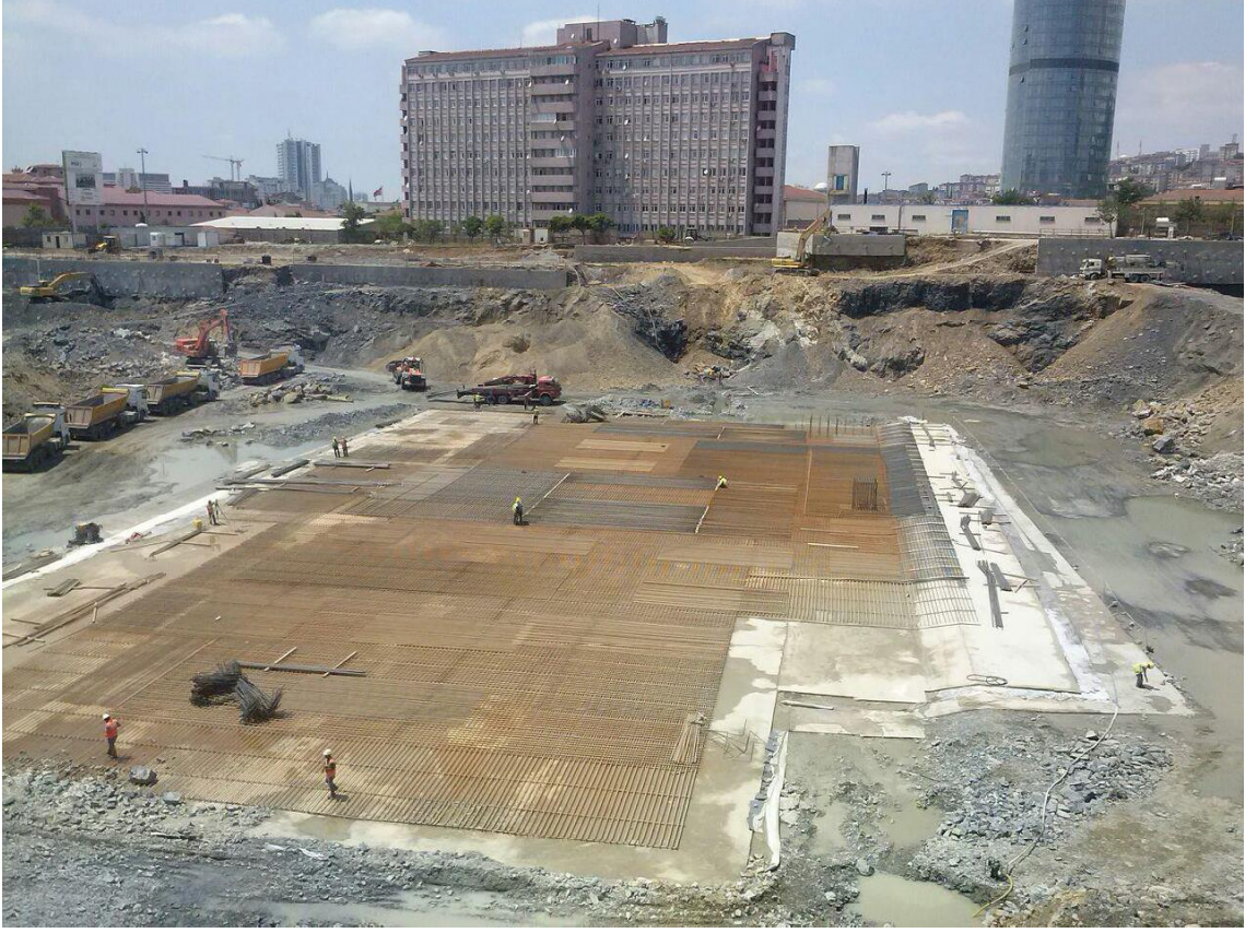
Şekil 3.6: Kartal Lütfi Kırdar Eğitim ve Araştırma Hastanesi Yeniden Yapılandırma Projesi Şantiyesinin Genel Görünümü
