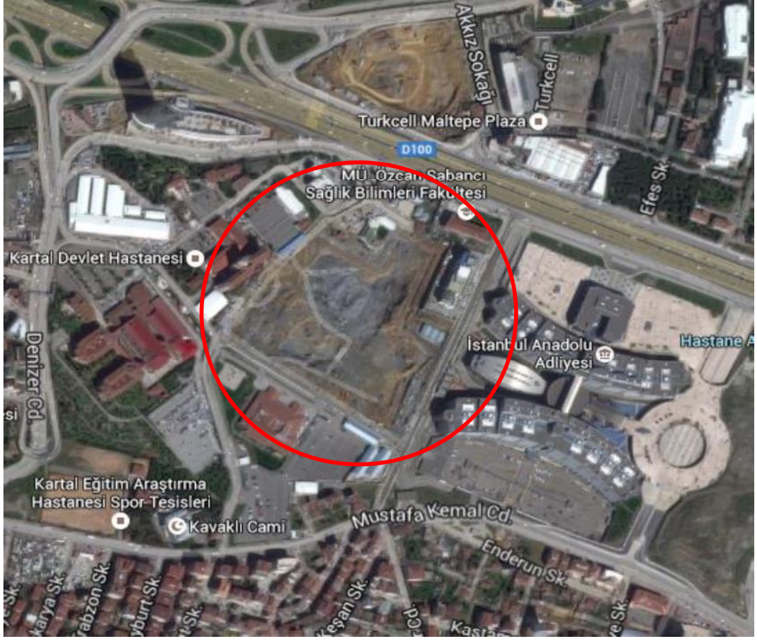
Şekil 3.5: Kartal Lutfi Kırdar Eğitim ve Araştırma Hastanesi Yeniden Yapılandırma Projesi İnşaatının Genel Görünümü (kaynak:Google).
