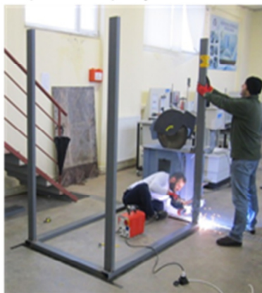
(h) Kutu dış iskeletini oluşturacak çelik dikmelerin taban profillerine kaynakılması işleminin ilerlemesi
