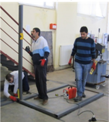
(g) Kutu dış iskeletini oluşturacak çelik dikmelerin taban profillerine kaynakılması
