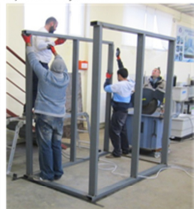
(ı) Kutu dış iskeletini oluşturacak çelik dikmelerin üst çelik kirişlerle sabitlenmesi
