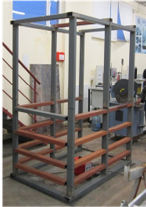
(l) Kutunun dış çelik iskeletinin yanıl profillerle güçlendirilmesi işleminin ilerlemesi
