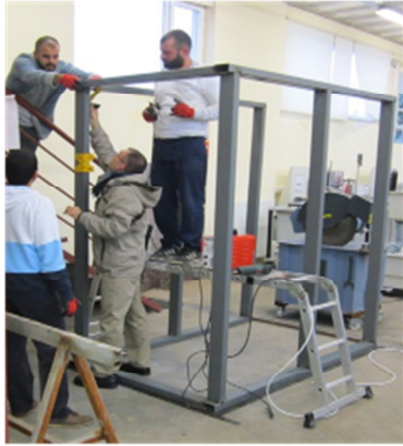
(i) Kutu dış iskeletini oluşturacak çelik dikmelerin üst çelik kirişlerle sabitlenmesi işleminin ilerlemesi
