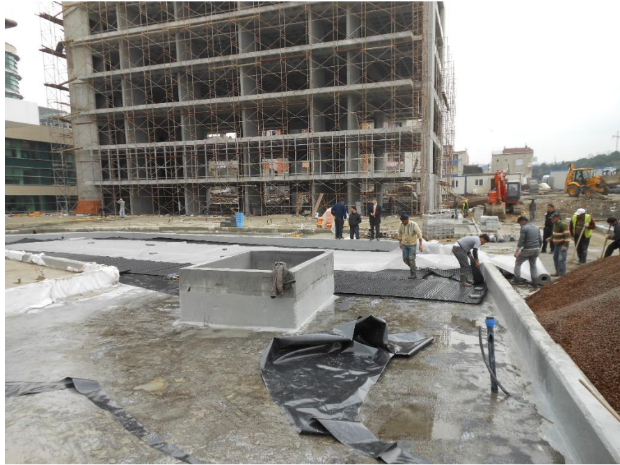
Şekil 2.10 Ana peyzaj adası geokompozit uygulaması
