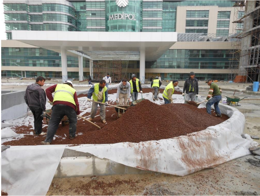
Şekil 2.11 Ana peyzaj adasında geokompozit tabaka üzerine granüler pomza uygulaması
