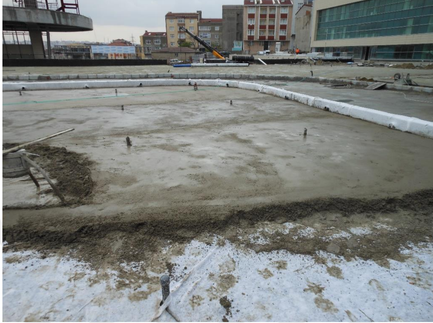
Şekil 2.9. Geofoam blok üzerinde yer alan yük yayma platformu üzerine geomembran ve geotekstil'den oluşan geokompozit üzerine tesviye şapı uygulaması
