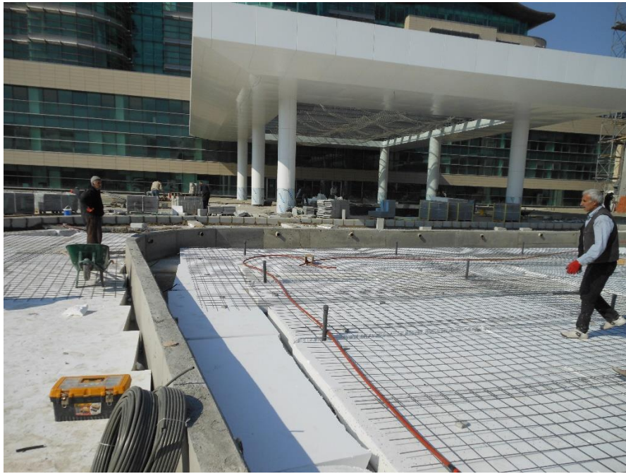
Şekil 2.8 Yansıma havuzu geofoam blok düzeni ve tesisat uygulaması
