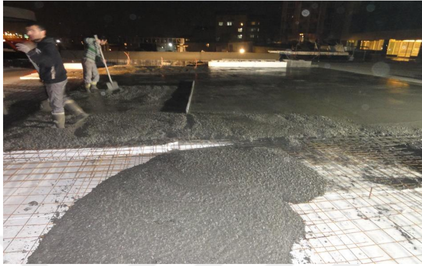
Şekil 2.6 Betonarme yük dağılımı platformunun yapım aşamaları
