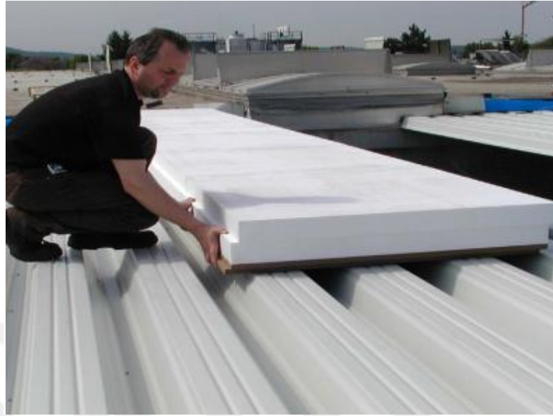
Şekil 1.2 Düz çatılarda EPS panel uygulamaları (EUMEPS, 2015)
