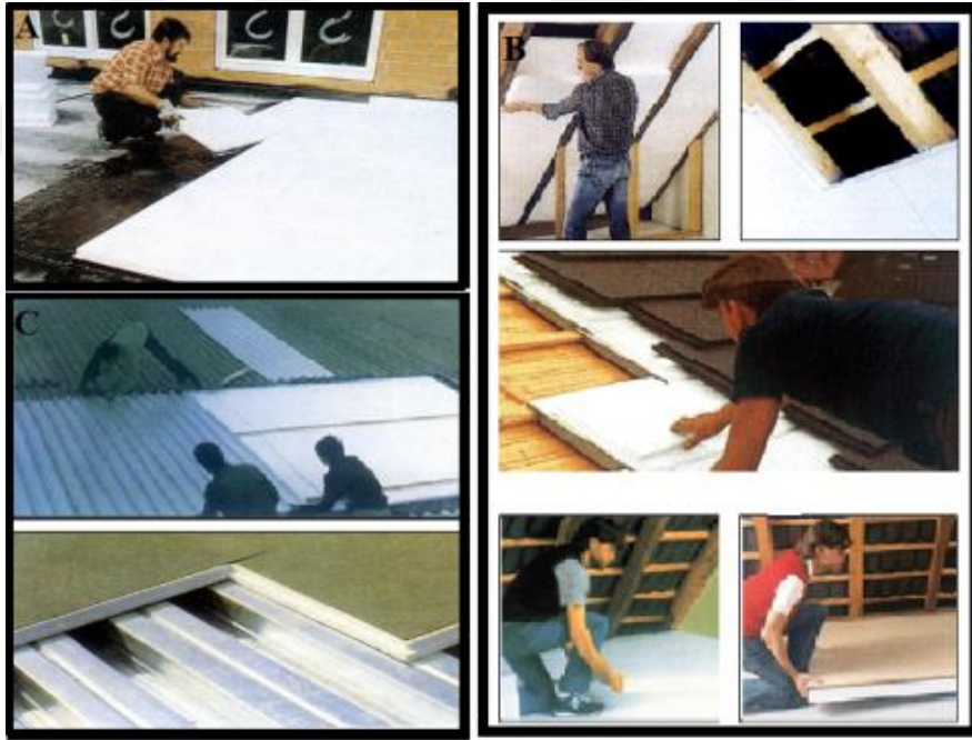
Şekil 1.1 Teras çatılarda hafif dolgu ve ısı yalıtımında EPS (a) Eğimli çatılarda EPS uygulaması (b-c) Meyilli ve az meyilli Sanayi Çatılarında EPS uygulaması (Delle Dekoratif Yapı Ürünleri)
