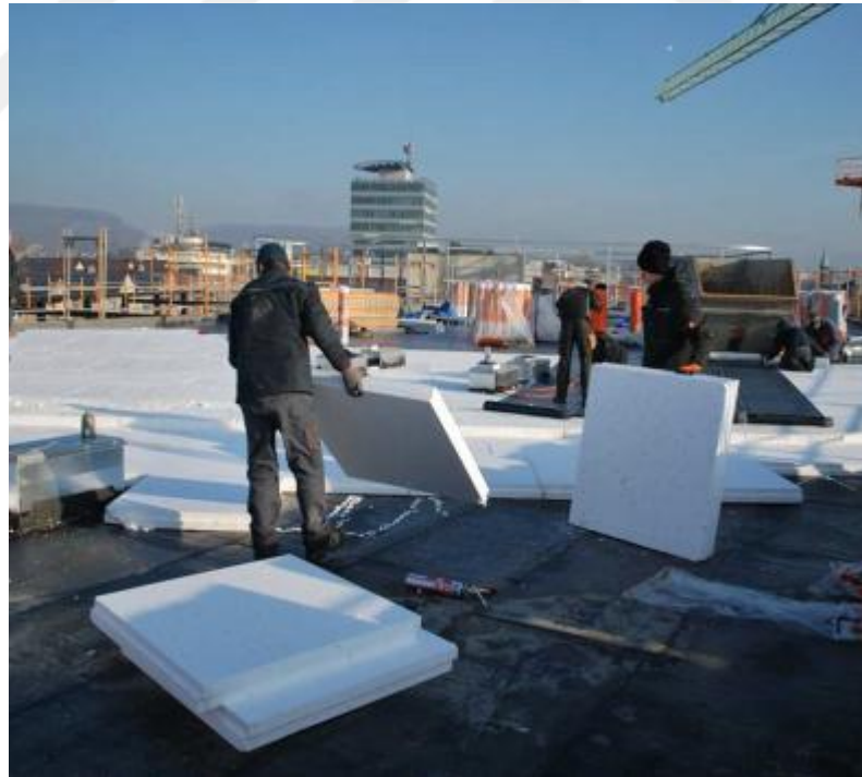
Şekil 1.3 Düz çatılarda EPS panel uygulamaları (EUMEPS, 2015)
