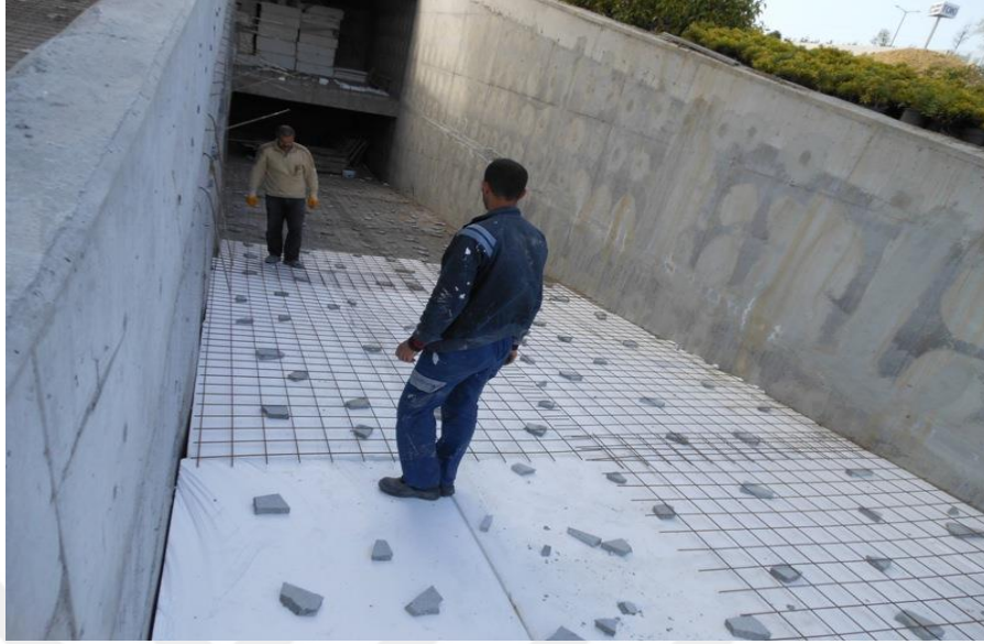
Şekil 2.13 Otopark rampa platformu geofoam blok dolgusu
