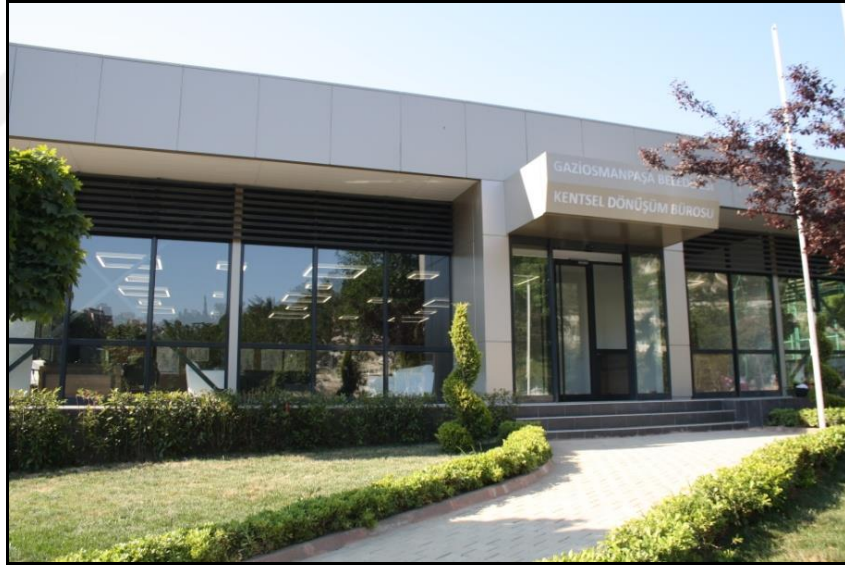
Şekil 5.17. Sarıgöl Mahallesi Kentsel Dönüşüm Bürosu (Dış Çekim)
