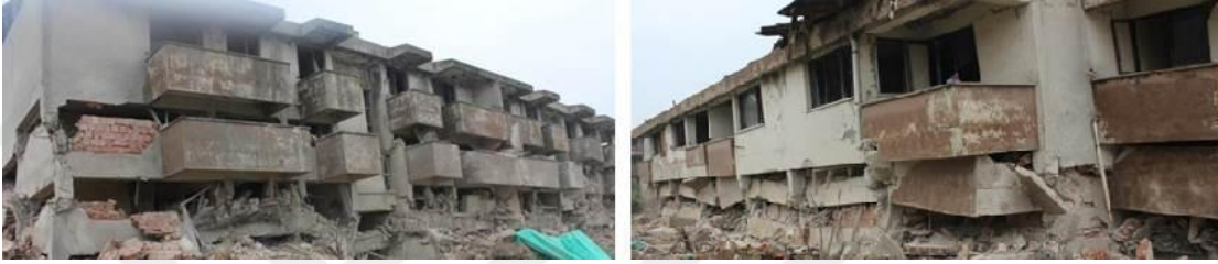
Şekil 4.5. Lojman binalarının patlatmalı yöntemle yıkıldıktan sonraki görüntüsü (ÖZYURT, ÖZER, & KARADOĞAN, 2013)
