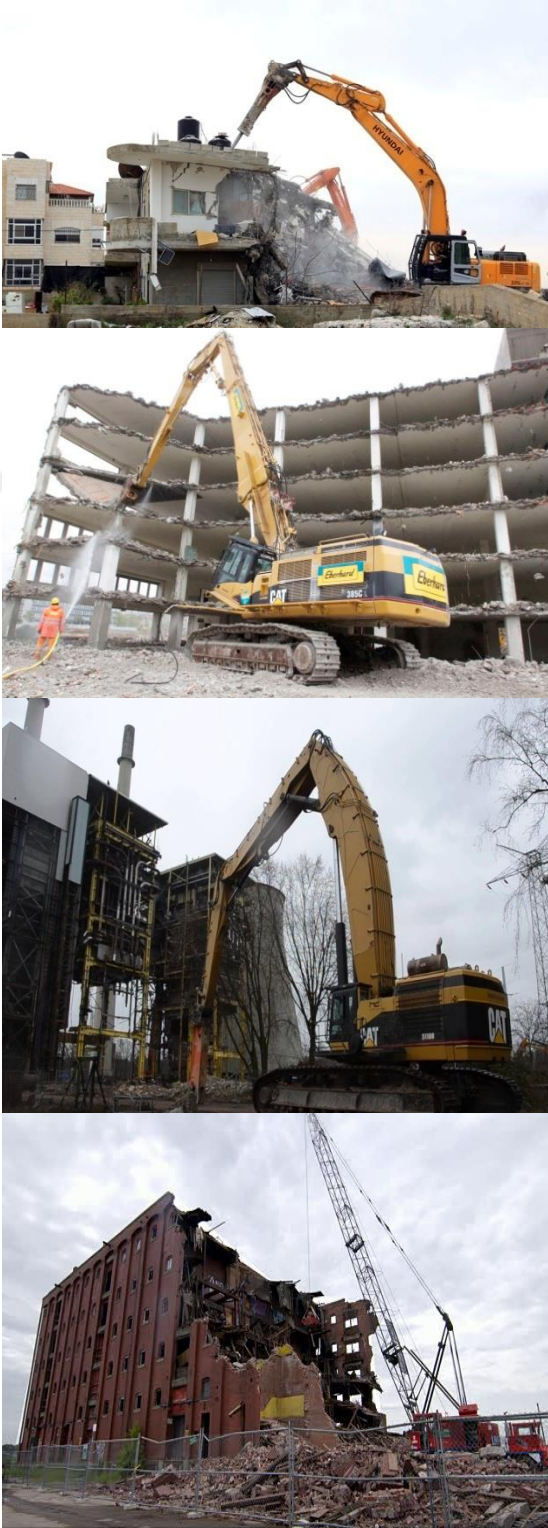
Şekil 3.4. Bazı Yapı Yıkım Makinaları
