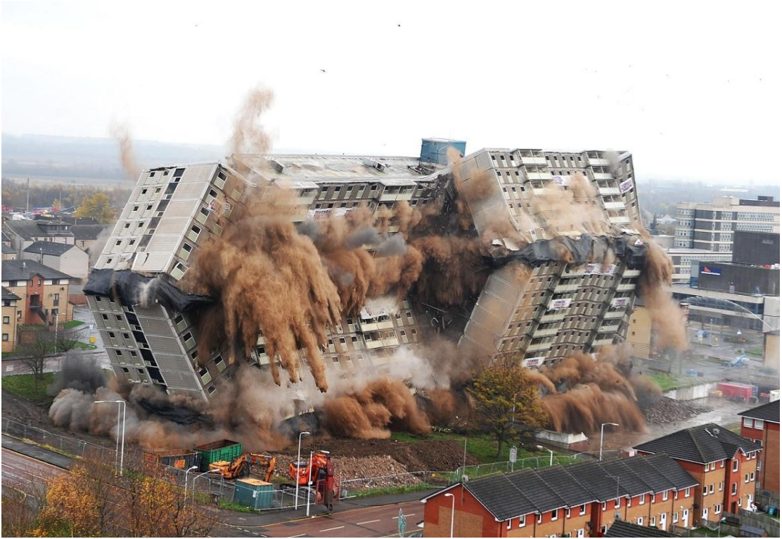
Şekil 4.1. Patlatmalı bina yıkımı görüntüsü
