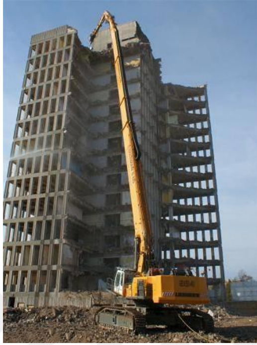
Şekil 4.2. Makine ile bina yıkımı
