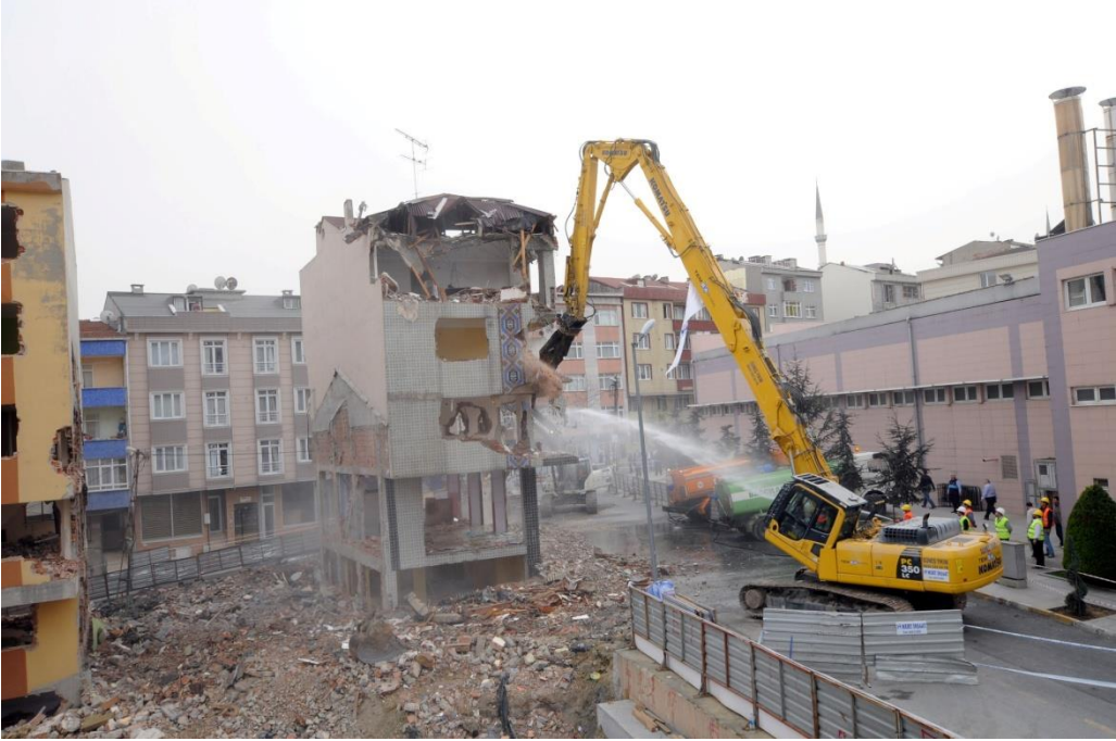
Şekil 2.1. Kentsel dönüşüm yıkım uygulaması
