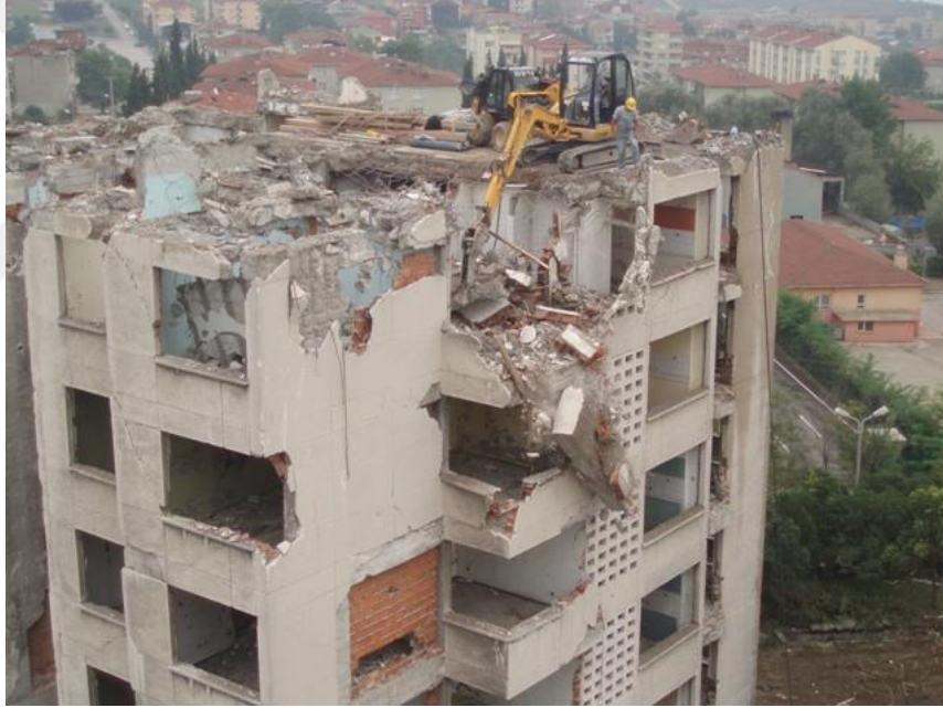
Şekil 3.5. Kat eksilterek bina yıkımı
