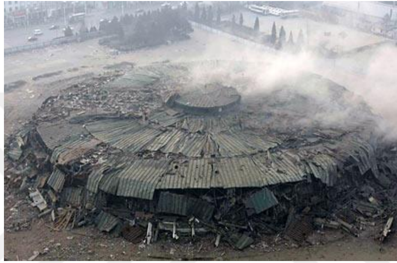
řekil 3.1. Yapının kendi iine ökertilerek yıkılması
