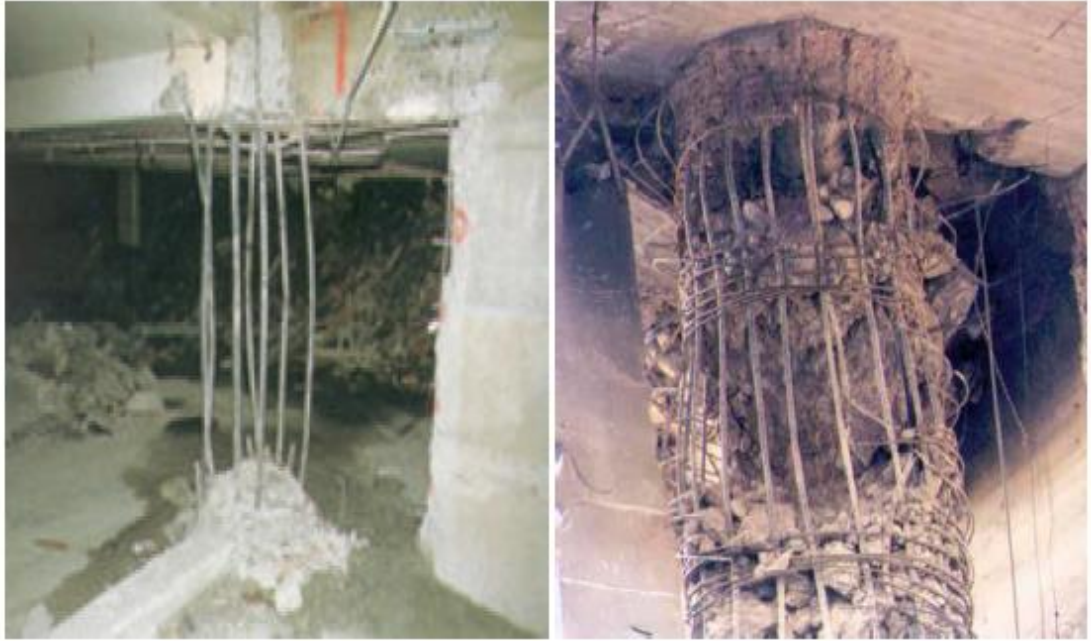
Şekil 3.3. Yıkım Öncesi Test Patlatması (KOCA, 2006)
