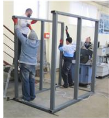
(i) Kutu dış iskeletini oluşturacak çelik dikmelerin üst çelik kirişlerle sabitlenmesi
