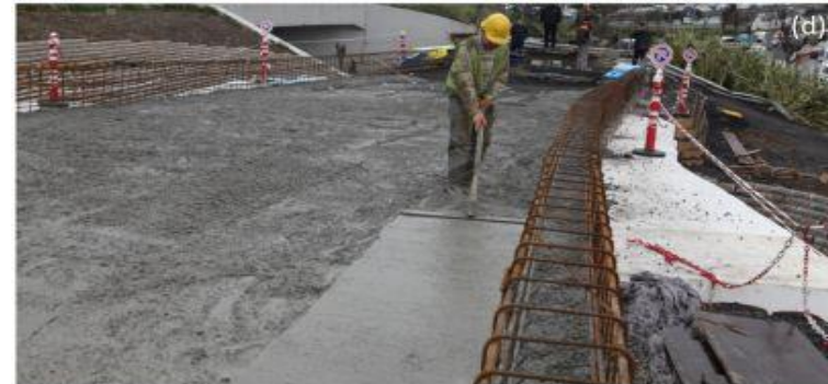
(d) Betonarme yük yayma platformu – geofam blok ara yüzeyi (Yer: Acıbadem, İstanbul; Fotoğraf: Emre Akınay, Tarih: 07.04.2017)
