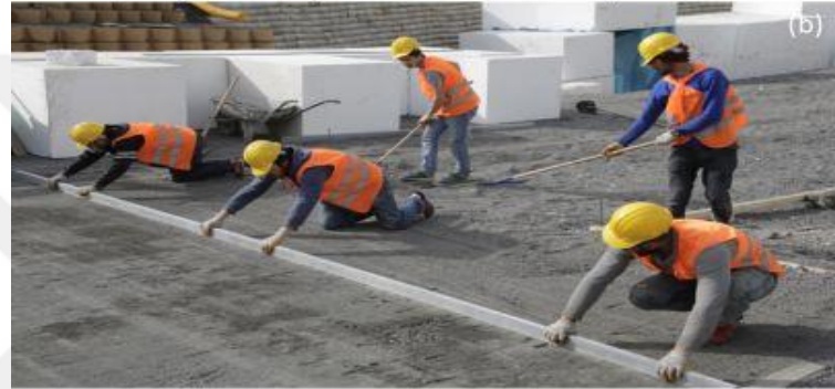
(b) Taban tesviye kumu – geofam blok ara yüzeyi (Yer: Acıbadem, İstanbul; Fotoğraf: Emre Akınay, Tarih: 04.03.2017)
