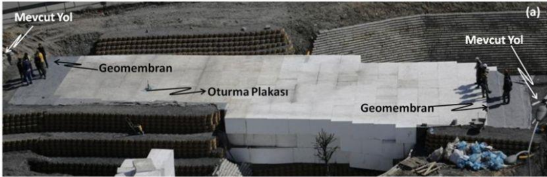
(a) Blok yerleşim planı tamamlanmış imalat (Yer: Acıbadem, İstanbul; Fotoğraf: Dursun Turna, Tarih: 30.03.2017)
