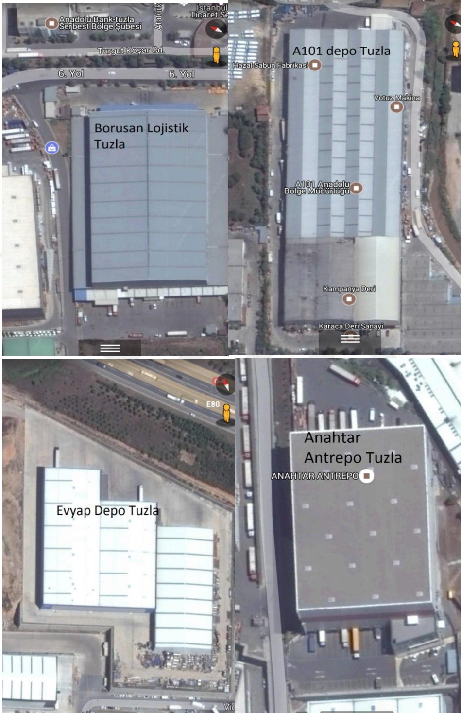
Şekil EK.1.3 Borusan Lojistik, A101, Evyap, Anahtar Antrepo Tuzla depoları (Google Earth, 2016)
