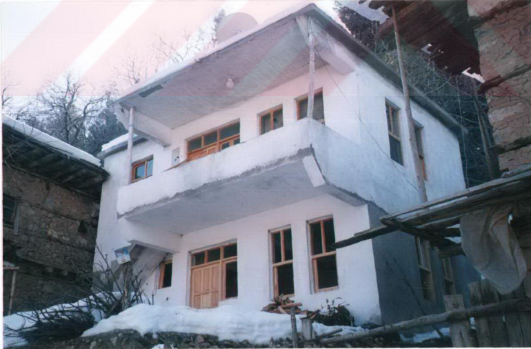
Foto 15 : Betonarme yapılara bir örnek
