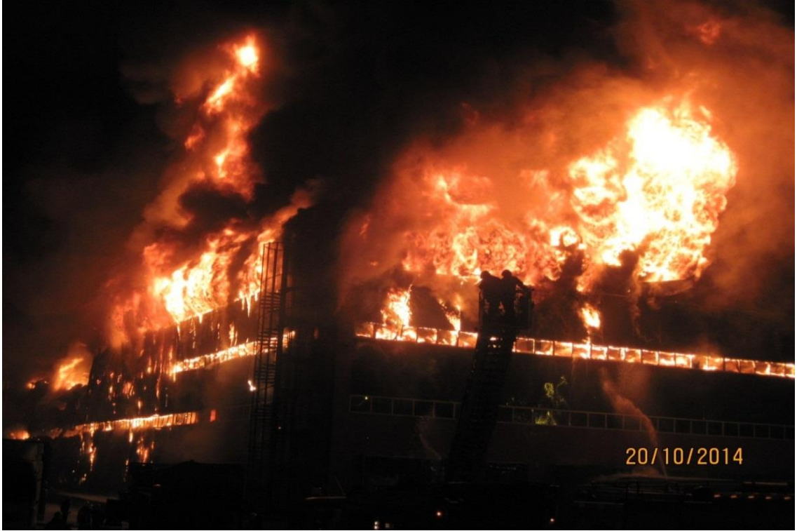
Şekil 7: Halkalı Gümrük Sahası Yangını, Bağcılar İtfaiyesinin Yangına Müdahalesi
