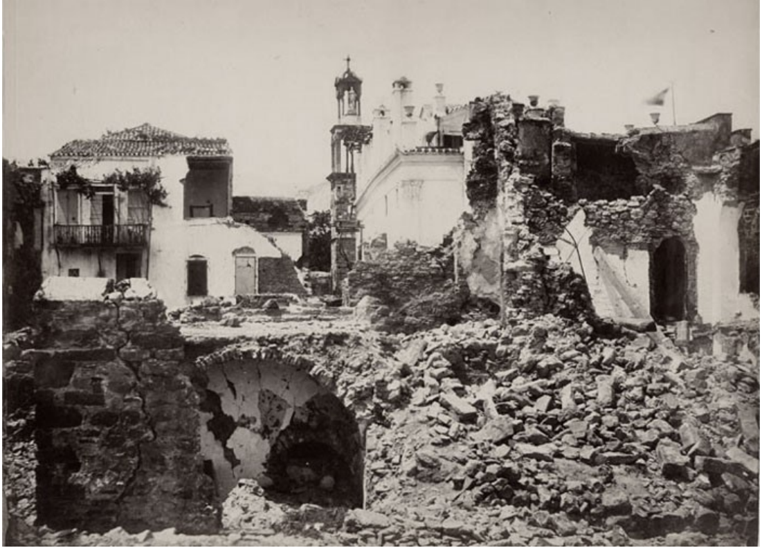
Foto.13: 1881 depremi sonrası doğu cephe tarafından görünüm 169 .
