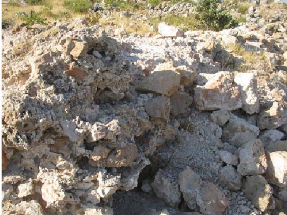
Fotoğraf 113: Temel Kalıntılarında Roma Harcı (Belören Kasabası)
