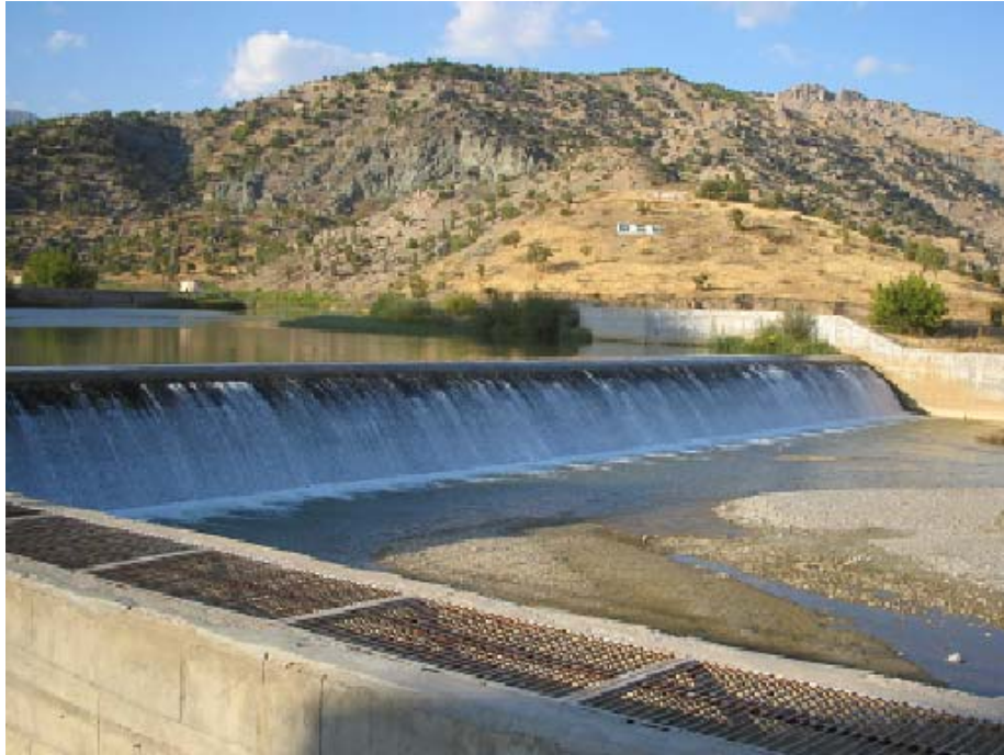
Fotoğraf 17: Gölbaşı Su Arıtma Tesisi
