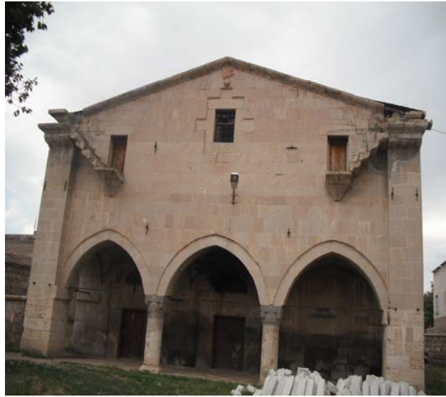
Resim 14. Dikilitaş Kilisesi I Önden Görünüşü
