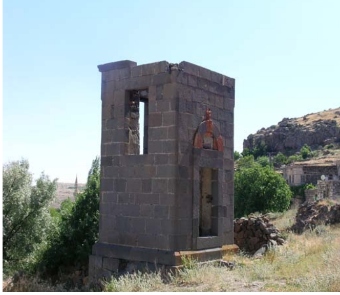
Resim 5. Ballı Çan Kulesi Ön Cephe Görünüşü
