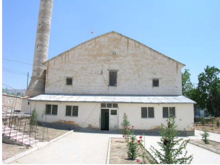
Resim 1. Aktaş Kilisesi Ön Cephe Görünüşü
