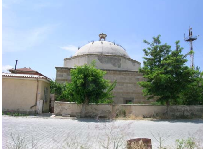
Resim 50. Fertek Hamamı Önden Görünüşü
