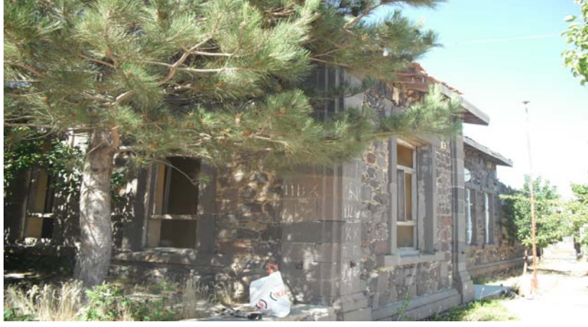
Resim 48. Ballı Rum Okulu Güney Batıdan Görünüşü
