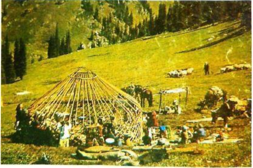
Şekil 18: Tanrı Dağları'nın (Tiyen-Şan) Doğu Türkistan cephesinde bir yamaçta yeni kurulmakta olan yurt'un (öyün) ahşap konstrüksiyonu. Tanrı Dağları'nda bozkır (step) kültürü yaşayışını aksettiren bir görünüş.
