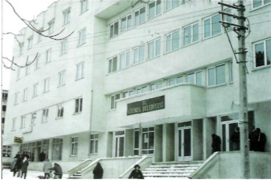
Fotoğraf 43: Siverek Belediye Binası
