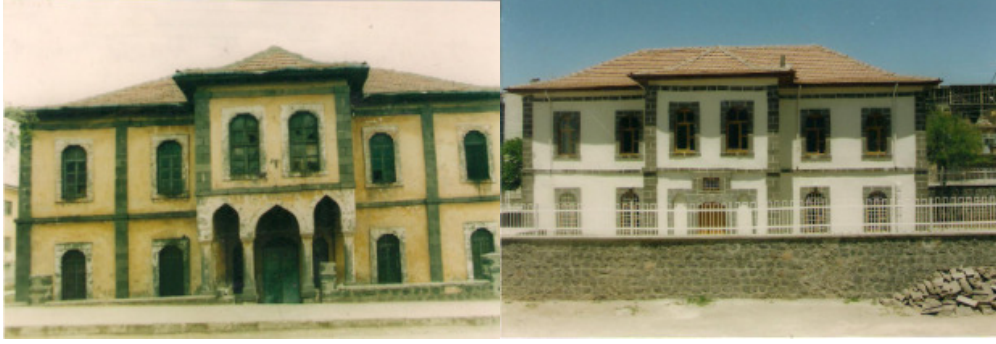
Fotoğraf 50: Gazi Paşa İ.Ö.O. Restore Edilmeden Önceki ve Restore Edildikten Sonraki Hali
