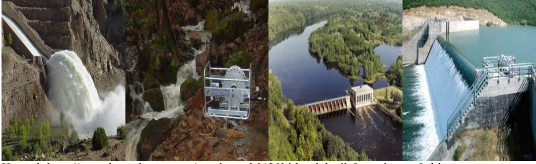
Resim 2.9: Küçük Hidroelektrik Santraller
