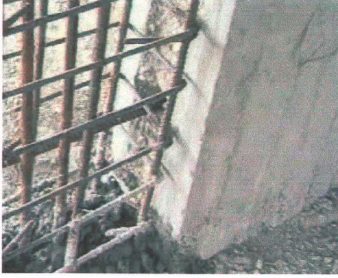
Foto 4.20 Yeni perdelerin mevcut kolonlara ankraj detayı (Gökçe, 2002)
