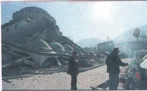
Foto 3.12 Kolon mafsallaşması sonucu toptan yıkım,17 Ağustos 1999 İzmit Depremi, Kaynaşlı (BBC)
