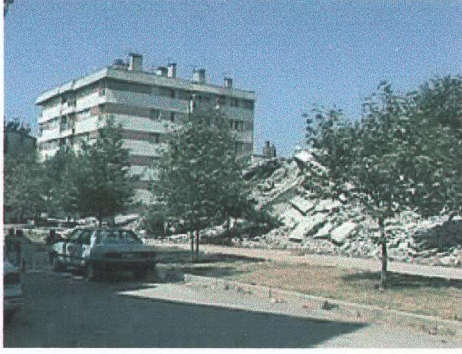
Foto 3.29 İki binadan birinin tamamen yıkılması malzeme kalitesizliğindedir,1998 Ceyhan Depremi (Çelebi, 1998)
