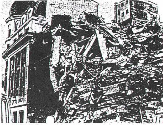
Foto 3.4 Aynı yapılara ait bir bloğun deprem sonrası durumu (Polyakov, 1981)
