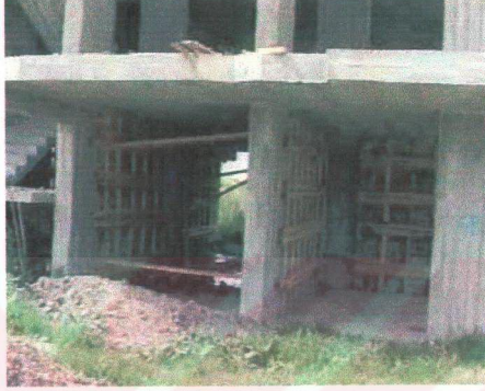
Foto 4.18 Güçlendirme çalışmaları çerçevesinde bir yapıya eklenen perdeler (Gökçe-2002)
