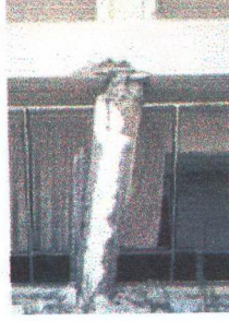
Foto 3.6 Olive View Tıp Merkezi tehlike katı mafsallaşması ve kolon ayrıntıları
