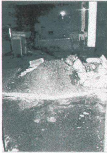
Foto 3.34 Sıvılaşma sonucu iki katlı bir evin zayıf temel grobetonunun patlaması , katın kumla dolması, 9 Ekim 1995 Manzanillo, Meksika Depremi, M=7,6 (EERI)
