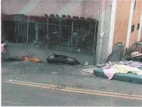
Foto 3.38 Aynı binanın 1.katının zemin kat seviyesine inmesi ve zemine gömülen bir araba (EERI)
