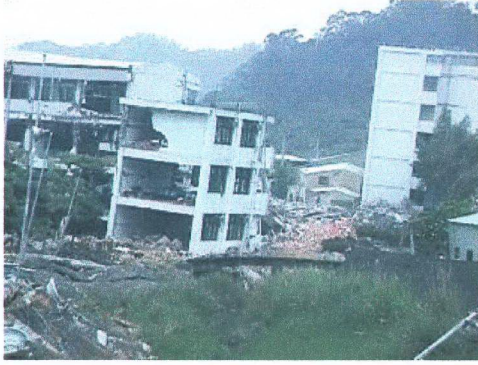
Foto 3.35 Wufeng'te, eski Vilayet Merkezi'ndeki bu binalar sıvılaşmadan hasar görmüşlerdir, 20 Eylül 1999, Tayvan Depremi (EERI)
