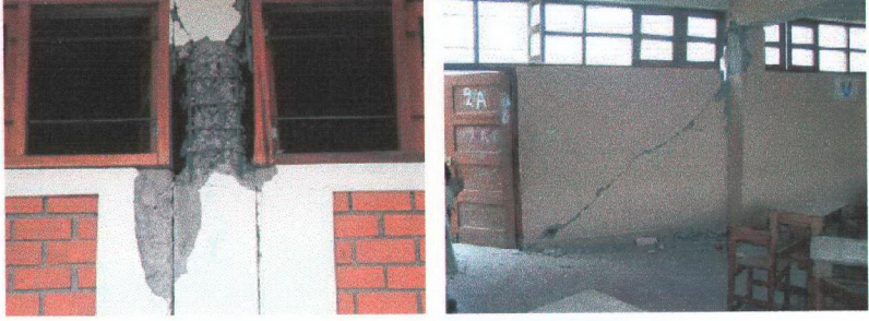
Foto 3.18 Aynı depremde bir başka okulda iki kısa kolon hasarı. Hasar sağdaki resimde dolgu duvarına da etkimiş ( Foto- Eduardo FIERRO).
