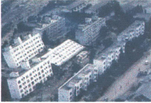
Foto 3.39 Zemin sıvılaşmasından ötürü bu yapı blokları kütle halinde bir yanlarına yatmışlardır, Niigata.16 haziran 1964 Niigata Depremi, Japonya, M=7,5 (EERI)
