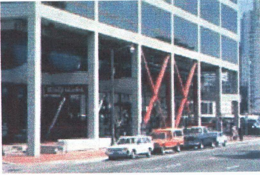
Foto 3.2 Açık cephenin diyagonal kirişlerle destelenmesi, San Fransisco (EERI)
