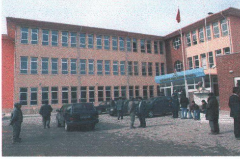
Foto 17 Hiç hasar görmemiş bir ilköğretim binası (Gökçe, 2002)
