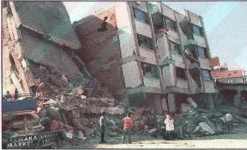
Foto 3.40 Zemin sıvılaşmasının etken olduğu ağır hasarlı bir yapı,17 Ağustos 1999 Kocaeli Depremi
