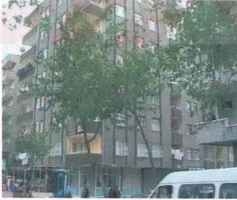
Foto 4.21 Güçlendirmesi tamamlanmış ve kullanıma açılmış bir yapı (Gökçe, 2002)
