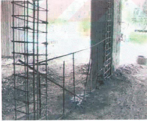
Foto 4.19 Mevcut kolonlar arasına perde ilavesi (Gökçe-2002)
