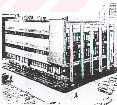
Foto 3.20 Kalın döşeme ve kirişler nedeniyle yıkılan bilgisayar binası, yıkılmadan önce, Karpatlar Depremi, Bükreş-ROMANYA
