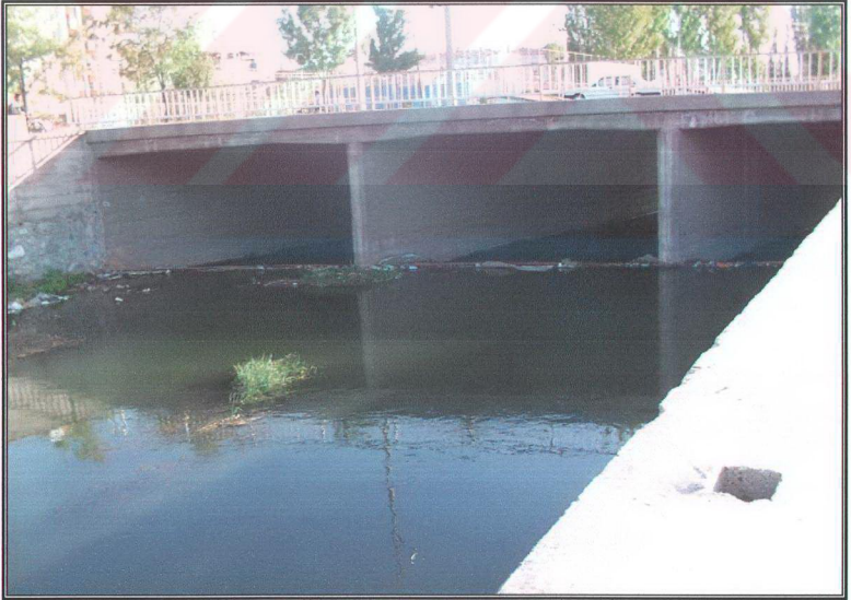
Foto 3.4 Tiyatro kavşağındaki 6 numaralı numune istasyonu önündeki köprünün görünümü
