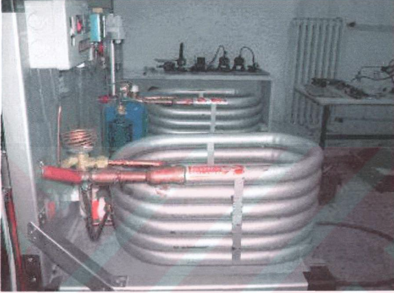
Şekil 3.14 Deney tesisatında buharlaştırıcının görünümü
