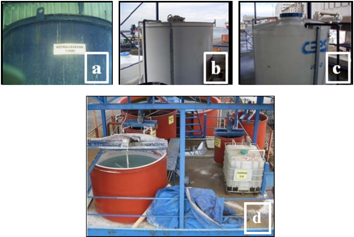
Fotoğraf 3.10 Haydarpaşa Limanı AKT arıtma tesisi nötralizasyon (a), kireç (b), PAC tankı (c), Martaş Limanı AKT arıtma tesisi nötralizasyon, kireç, PAC tankları (d)
