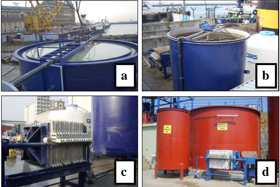
Fotoğraf 3.11 Haydarpaşa Limanı AKT arıtma tesisi kimyasal durultucu tankı (a), çamur yoğunlaştırma (b) ve filtre pres (c); Martaş Limanı AKT arıtma tesisi kimyasal durultucu tankı, çamur yoğunlaştırma tankı ve filtre pres (b)
