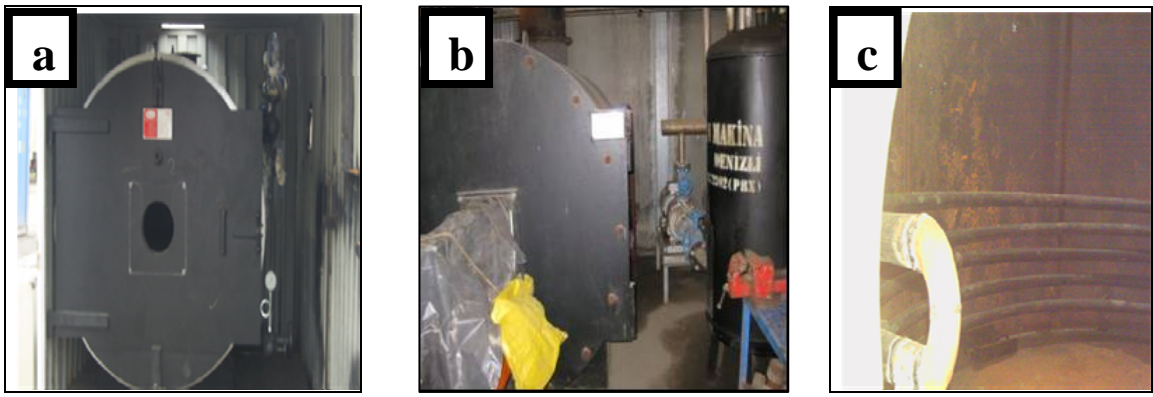
Fotoğraf 3.7 Haydarpaşa ve Martaş Limanı AKT'leri kızgın yağ kazanları (a, b), Haydarpaşa ve Martaş Limanı AKT'leri depolama tankı serpantinleri (c)
