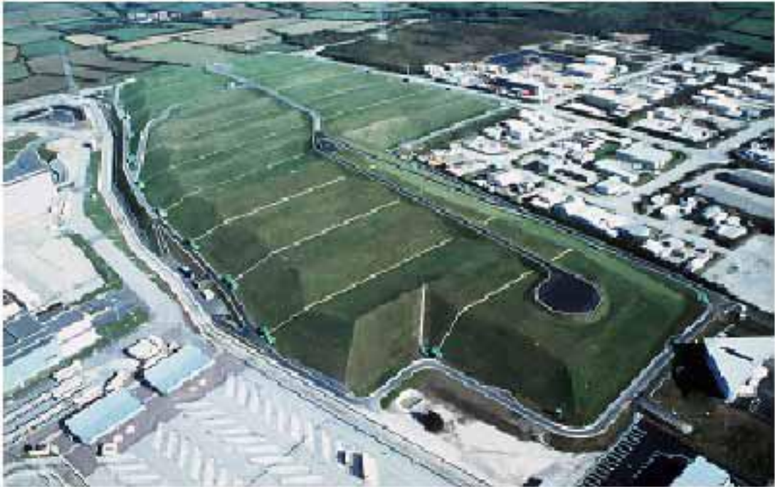
Fotoğraf 5.3. Düşük düzeyli atık depolama alanı – Centre de la Manche(Fransa) (Dutzer vd.,2014)
