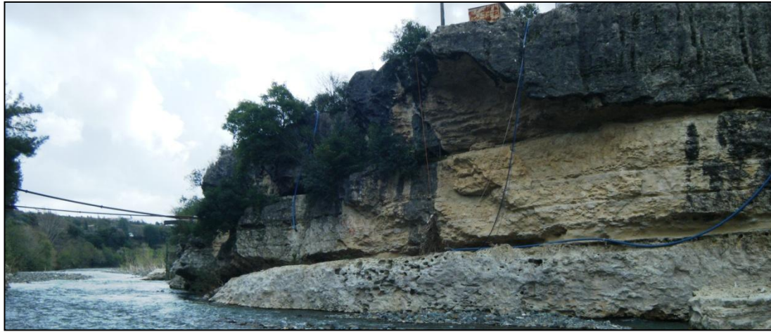
Foto 42. Yüksek Poroziteye Sahip Miyosen Kalkerleri
