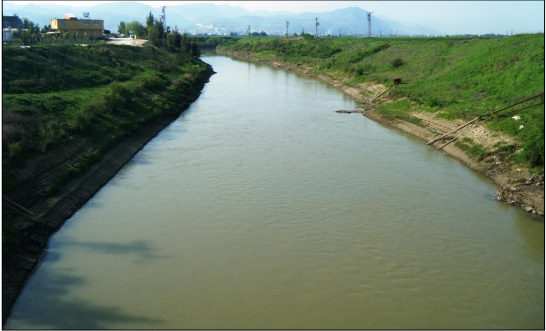
Foto 48. Küçük Asi Kanalı'ndan Santrifüjle Sulama Suyu Çekilen Borular
