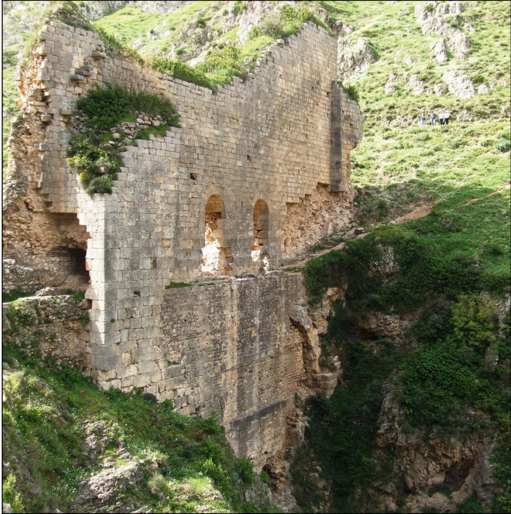
Foto 44. Antakya'nın Kuzeydoğusundaki Demirkapı Seddi
