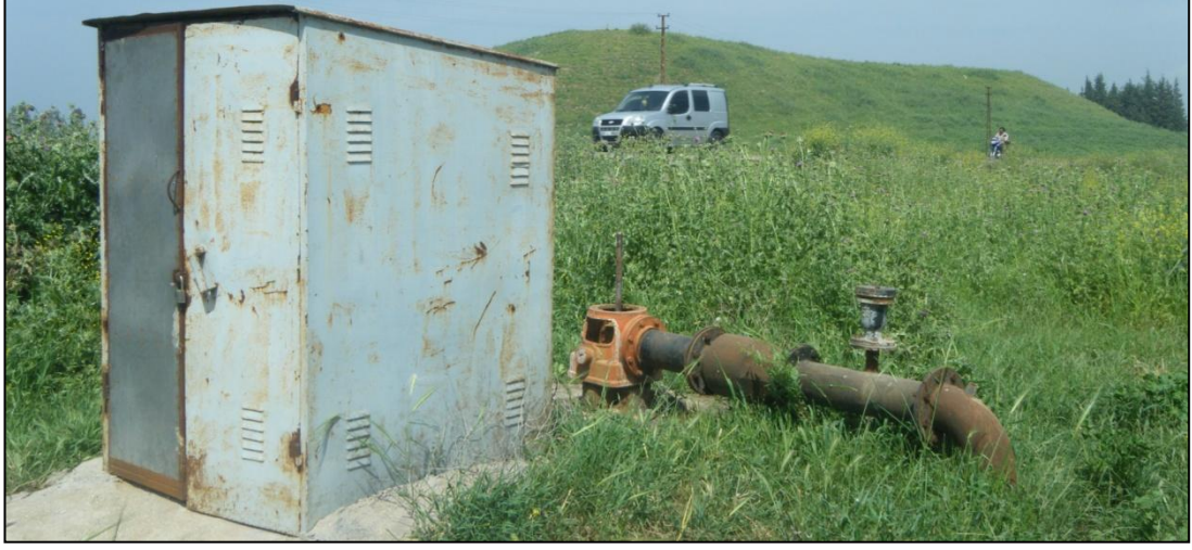
Foto 29. Koyuncuhöyük Güneyinde Kapalı Durumdaki Mineralli Su Kuyusu ve Kaptajı
