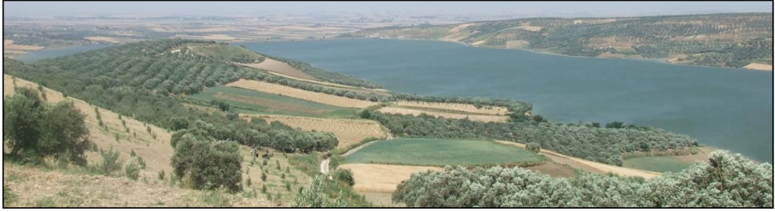
Foto 15. Yarseli Barajı ve Çevresindeki Tarım Alanları
