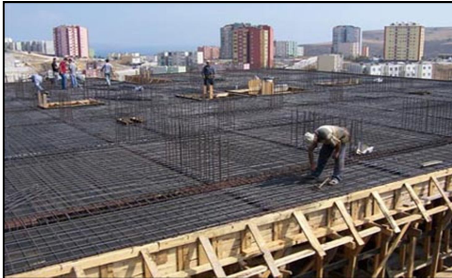
Resim 11: Suudi Arabistan’da İnşaat Sektöründe Çalışan Türk İşçilerinden Görünüş.
